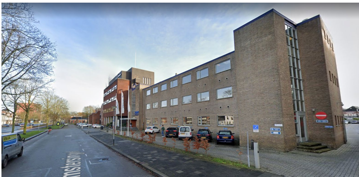
Figuur 3-8 Certe-gebouw, vanaf het Damsterdiep
