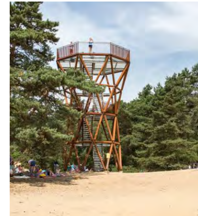
Houten uitkijktoren van zo'n 8 tot 10 meter hoog
