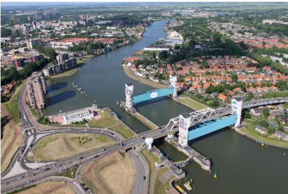
Figuur 2.2: De Hollandsche IJsselkering bestaat uit twee schuiven (blauw) en links daarvan een schutsluis.
