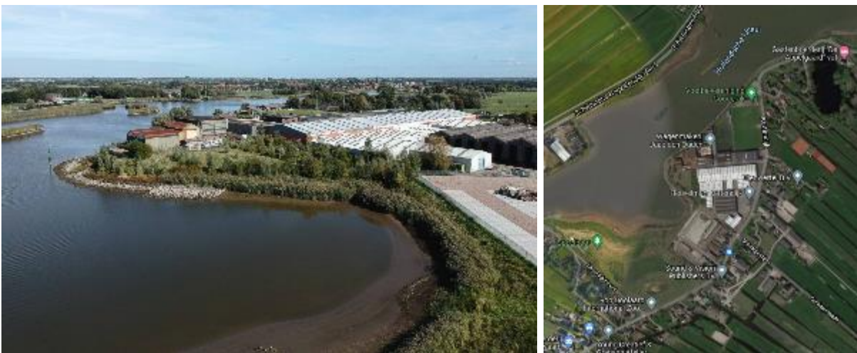
Figuur 2.6: Voorlanden zijn buitendijkse terreinen die samen met de dijk de waterkering vormen (foto met zicht op het voorland en van boven).
