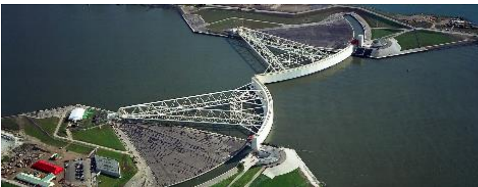
Figuur 2.3: De Maeslantkering gaat pas bij veel hogere waterstanden dicht dan de Hollandsche IJssel kering.
