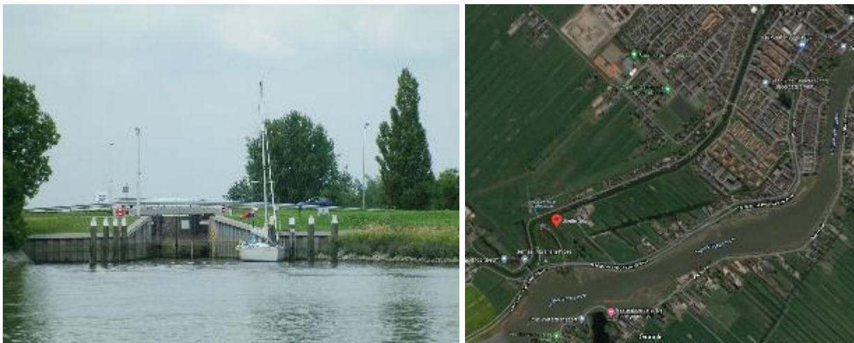
Figuur 2.8: De Hollandsche IJssel wordt ook als zoetwatervoorziening gebruikt voor het achterland (foto: een van de waterinlaatsluizen en van boven is de locatie gemarkeerd met een rode marker).
