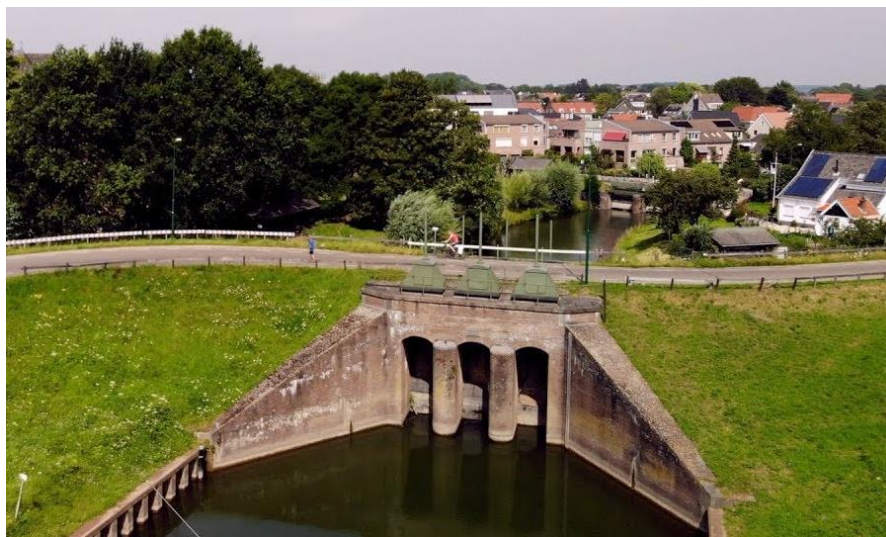
Sterke Lekdijk: HIA Inundatiesluis Nieuwe Hollandse Waterlinie
