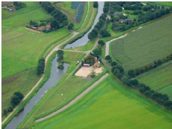
luchtfoto van locatie vanuit het noordoosten
