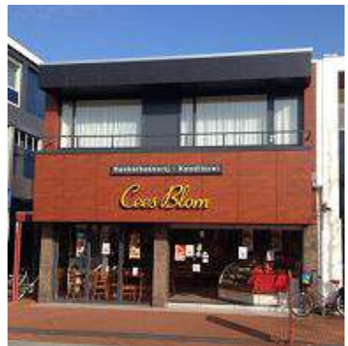
Enheid in gevelbeeld (na de verbouwing)
