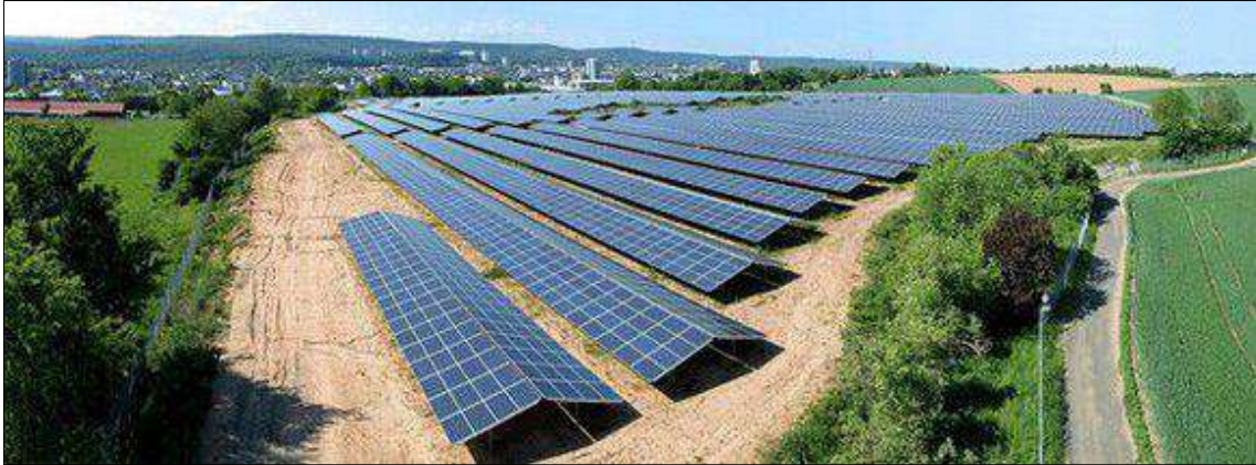
Oost-west oriëntatie met zadeldakopstelling
