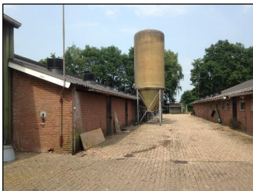
Foto 15. Te slopen varkensstallen
