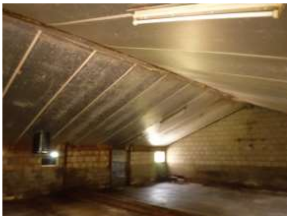
Stal 3 volledig gesloten dakisolatie van dupanel.
