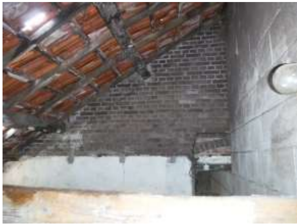
Stal 1: pannen dakbedekking, houten dakconstructie; geen isolatie.
