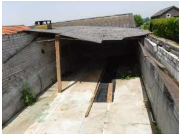
Stal 2: gedeeltelijke dakbedekking van golfplaten.
