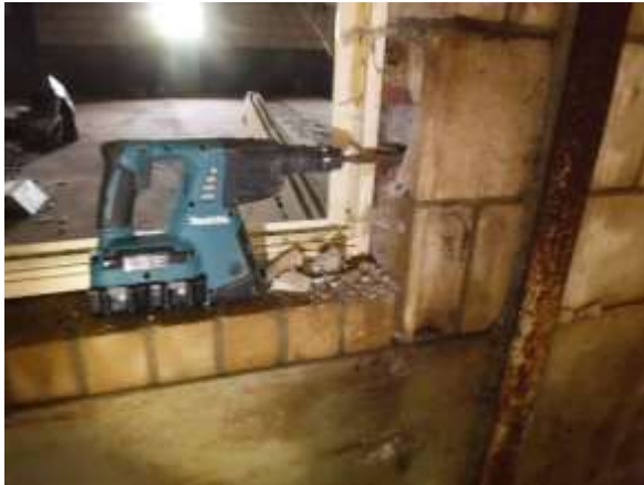
Spouw geïnspecteerd: geen verdachte materialen aangetroffen.
