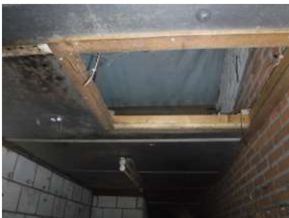
Stal 5 en stal 6 isolatiefolie onder de golfplaten.
