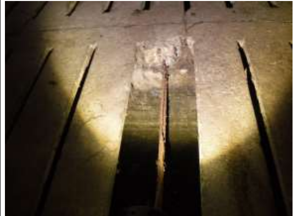
Betonnen roosters en putwanden geïnspecteerd.
