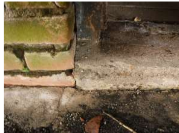
Detail houten kozijn en vloer.
