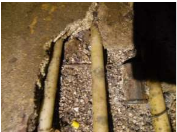
Betonvloer ligplaats geïnspecteerd: vloerverwarmingsbuizen en isolatie zichtbaar.
