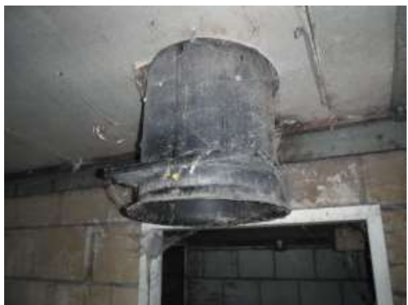
De ronde ventilatiekoekers zijn gemaakt van kunststof.
