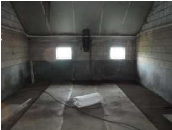
Betonnen vloeren met metalen roosters.
