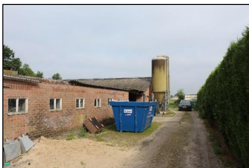
Foto 3. Te slopen varkensstallen
