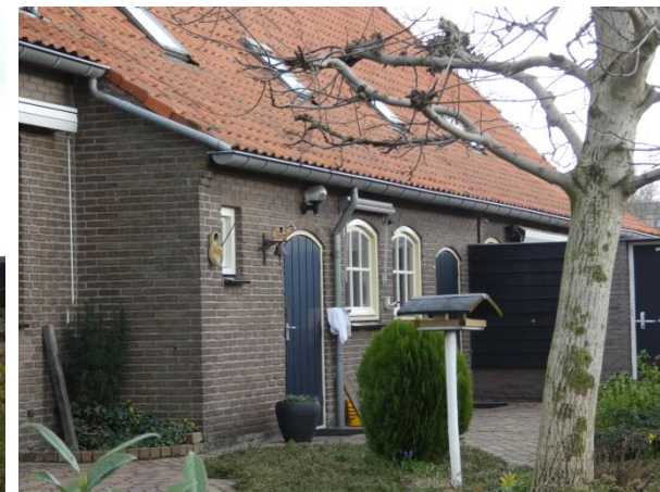
De oorspronkelijke uitbouw tegen het achterhuis, waarbij de venster- en deurstructuur is behouden.
