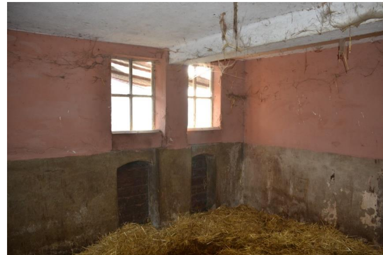
Interieur vm. varkensstal. Hierboven zou zich een plafond van holle baksteen moeten bevinden.
