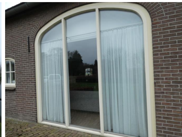
Poortopening onder korfboog: de naar binnen draaiende poorten zijn vervangen door een pui.
