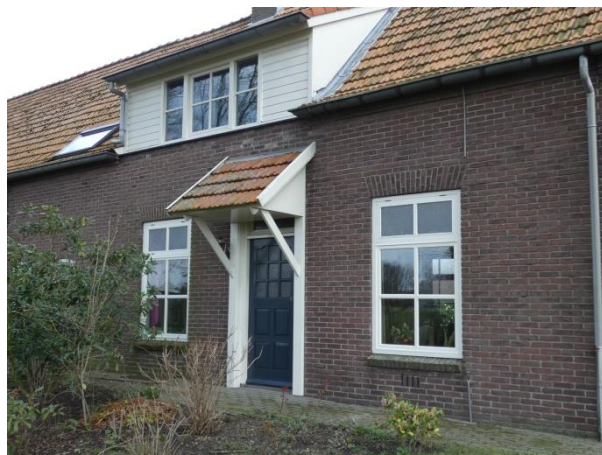
Symmetrische opzet gevel voorhuis met vensters onder hanenkam. De luifel en kapel zijn later toegevoegd.
