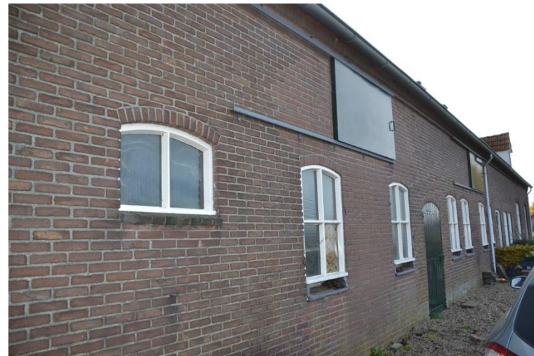
Linkerdeel van linkerzijgevel vanuit het noorden gezien.
