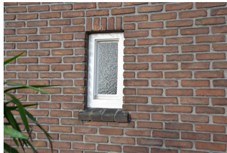
Het kleine venster links in de gevel van het woongedeelte.
