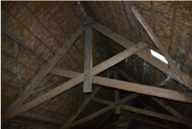
Gordingkap met houten verstijfde en verbeterde Hollandse spanten.
