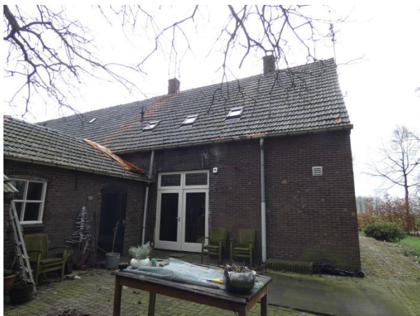
Noordgevel van het voorhuis. Het keukenvenster is naar beneden toe verlaagd tot tuindeuren.
