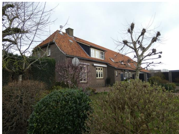
Achtergevel (zuidgevel) van het voorhuis.
