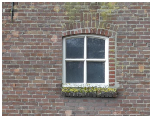
Centraal venster in de oostgevel. Het enige venster waar naast de segmentboog met kuif ook de bakstenen lekdorpel is bewaard.
