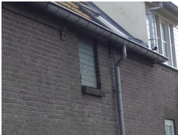
Hooiluik, waarbij de uitkragende baksteenlijst wordt afgesloten door bakstenen consoles.
