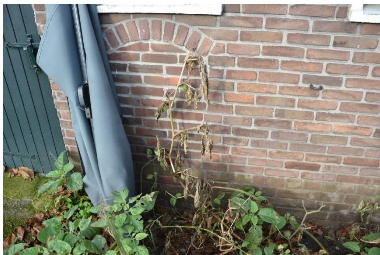
Detail van de dichtgezette varkensdeuropening. De duimen zijn nog in het metselwerk aanwezig.
