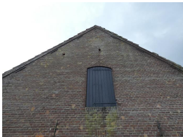
Groot authentiek hooiluk met geheel boven in de nok een dichtgezet rond uilengat.
