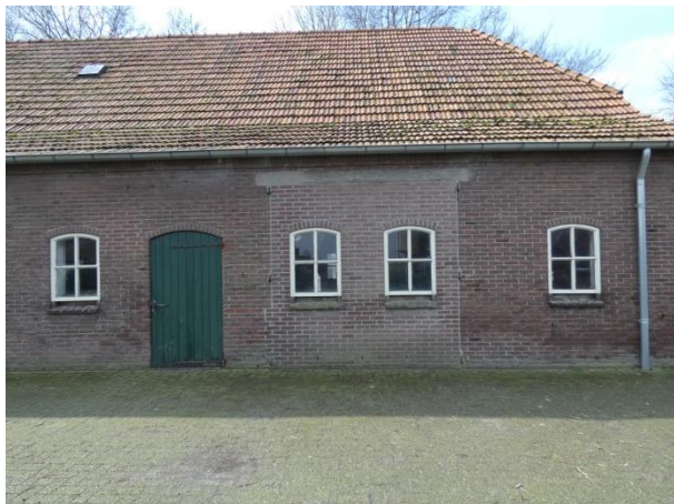
De locatie van de poort onder latei is nog duidelijk herkenbaar. Ook de duimen zijn nog aanwezig.
