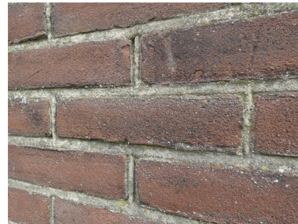
Knipvoegjes bij de stootvoegen.
