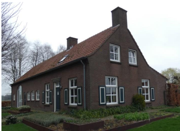
Noord- en westgevel.
