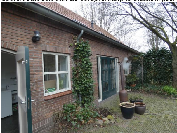
Linker gedeelte van de achtergevel van het achterhuis.
