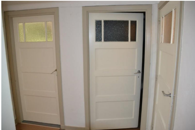
Authentieke paneeldeuren met kozijnen en houten dorpels op de verdieping.
