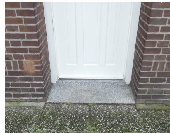
Detail van de verdiepte geplaatste entree met granito stoepje.
