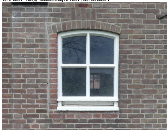
De jaren vijftig-zestig betonvensters zijn in het oorspronkelijke vensteropening geplaatst, met behoud van de segmentboog met kuif.
