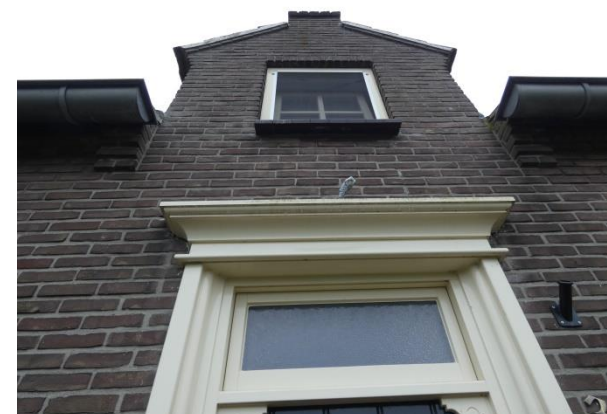
Detail van de deuromlijsting en de Vlaamse gevel.
