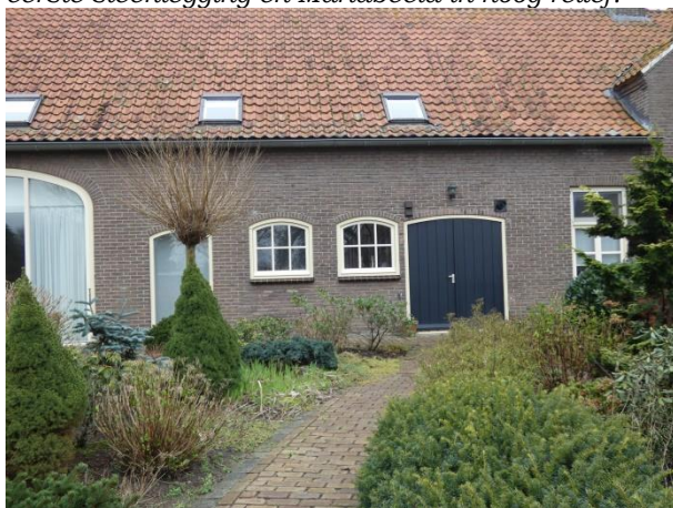
Rechter gedeelte van de noordgevel van het achterhuis. Ter plekke van de kleine poort zat oorspronkelijk een stalraam.
