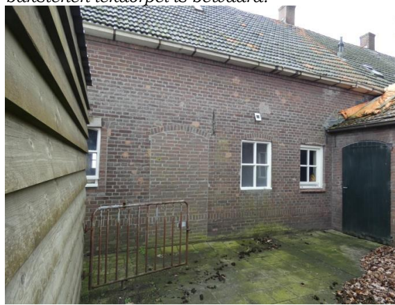
Dichtgemetselde staldeur en twee detonerende vensters onder de smallere segmentbogen.
