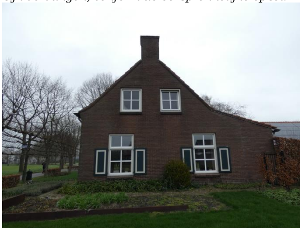
Westelijke kopgevel met geheel rechts de uitbreiding van het voorhuis.
