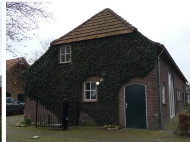
De oostelijke kopgevel met wolfseind. De staldeur rechts is later toegevoegd. De sporen van de voormalige staldeurtjes zijn nog herkenbaar.
