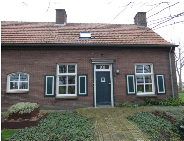
Voorgevel van het voorhuis: De vensters en luiken zijn vervangen, conform de oorspronkelijke opzet.
