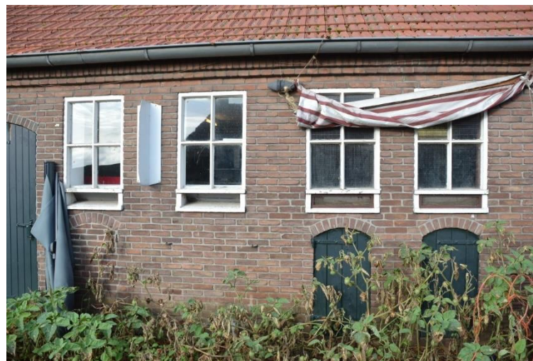
Betonnen stalramen met daaronder de varkensdeurtjes.
