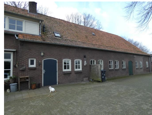
De gevel van het achterhuis met oorspronkelijke indeling. Links de twee vervangen betonvensters.
