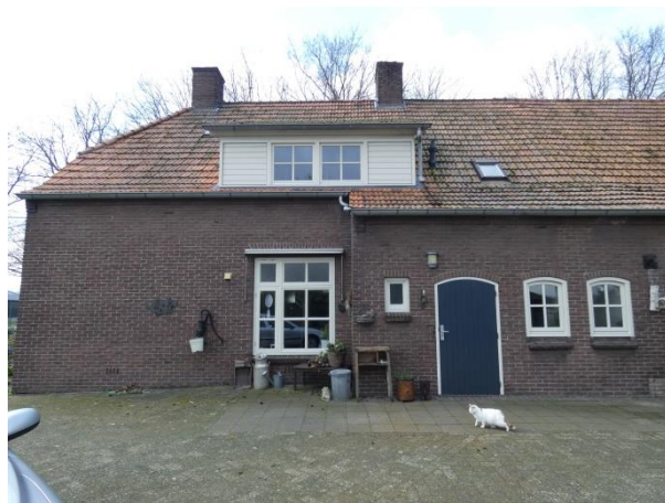
Oostgevel: links het voorhuis. Rechts de uitbouw van het achterhuis met (voorbij de brandmuur) het toilet.
