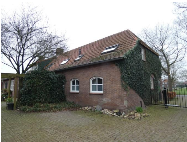
Achtergevel van het achterhuis: rechter gedeelte.
