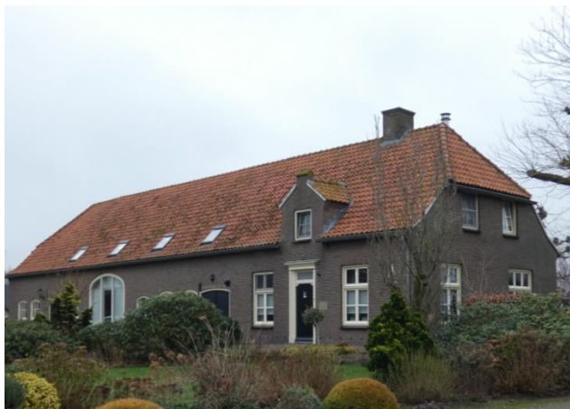
Noord- en oostgevel.
