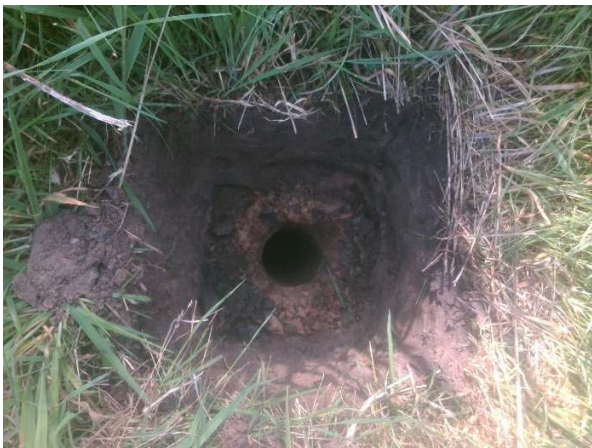
Fotonummer: 3 Omschrijving: Inspectiegat B001
