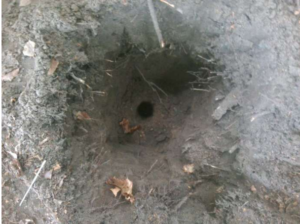
Fotonummer: 25 Omschrijving: Inspectiegat C017
