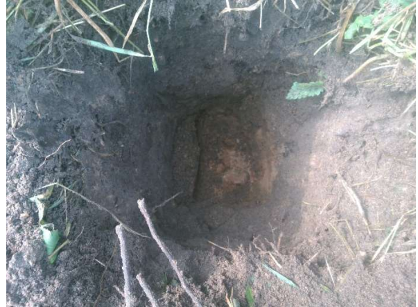
Fotonummer: 8 Omschrijving: Inspectiegat C003
