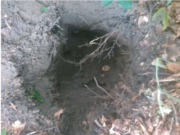
Fotonummer: 21 Omschrijving: Inspectiegat C011
