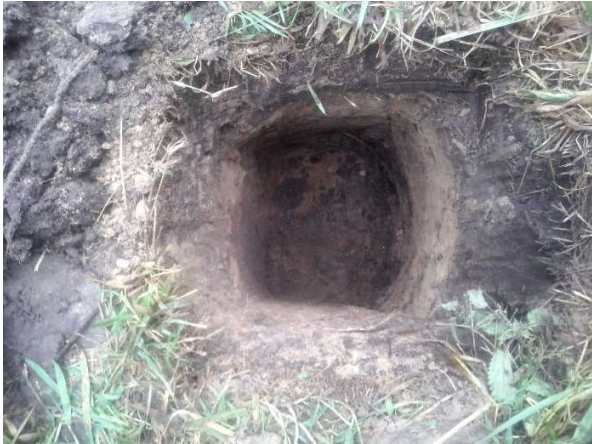
Fotonummer: 1 Omschrijving: Inspectiegat A316
