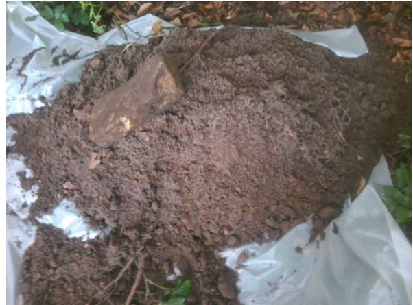
Fotonummer: 22 Omschrijving: Inspectiegat C011
