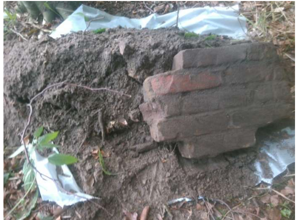
Fotonummer: 14 Omschrijving: Inspectiegat C006
