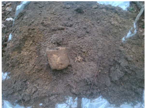
Fotonummer: 18 Omschrijving: Inspectiegat C008
