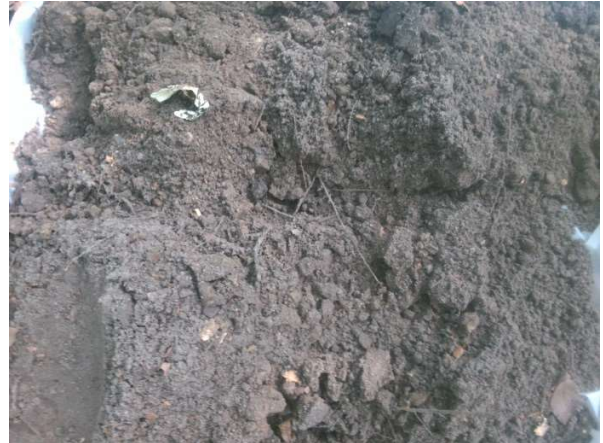
Fotonummer: 10 Omschrijving: Inspectiegat C004
