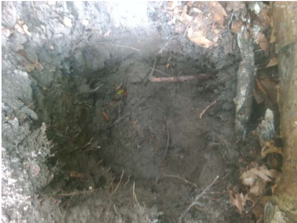
Fotonummer: 13 Omschrijving: Inspectiegat C006
