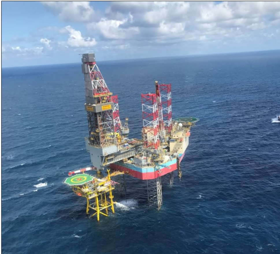
Figuur 3.2: Voorbeeld van een zelfheffend boorplatform (rechts) tijdens uitvoering van een boring bij een satellietplatform (links)
