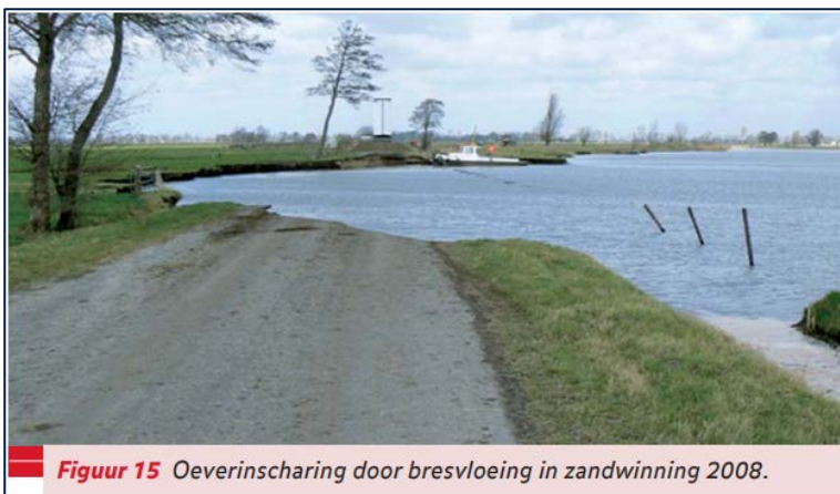
Figuur 5-6 Voorbeeld Oeverinscharing Bron Geotechniek Juli 2009 [x]
