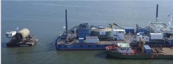
Afbeelding 4-9: Voorbeeld van de aanvoer van kabels naar een locatie op het Wad
