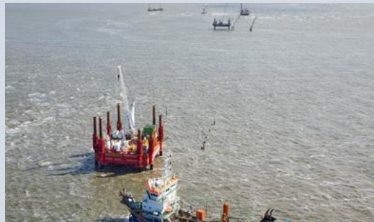
Afbeelding 4-6: Voorbeeld van een HDD-boring (op zee)
