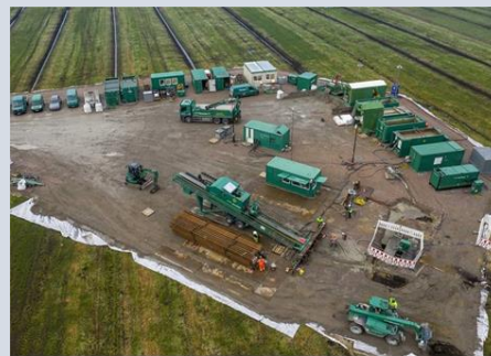
Afbeelding 4-8: Voorbeeld van een werklocatie (HDD-boring) op land
