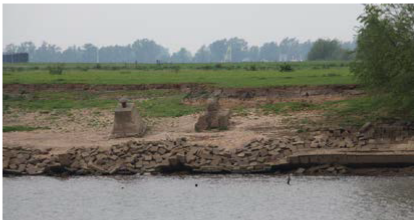
Figuur 3.5 Impressie verzakte verdediging westelijke oever veerhaven
