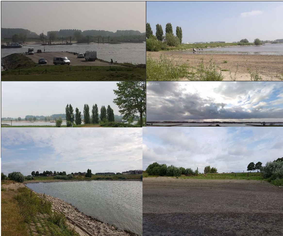
Figuur 2-8: Foto's plangebied rond de haven. Van links naar rechts en boven naar beneden: loswal, strandje veerhaven, toeritten naar veerstoepen, toegangsweg loswal, havenkom met zichtbare hoogtesprongen en aanlanding
