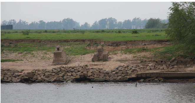
Figuur 5-7 Impressie verzakte verdediging westelijke oever veerhaven
