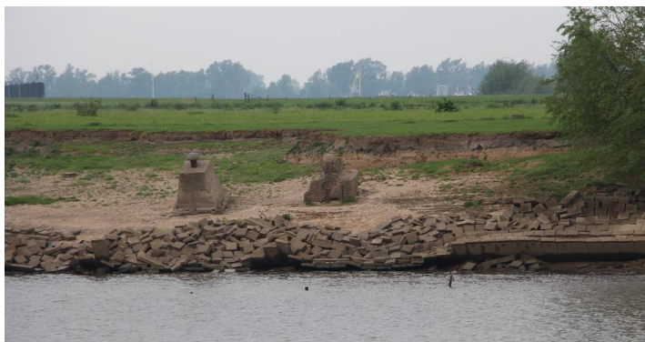
Figuur 3-1 Impressie verzakte verdediging westelijke oever veerhaven
