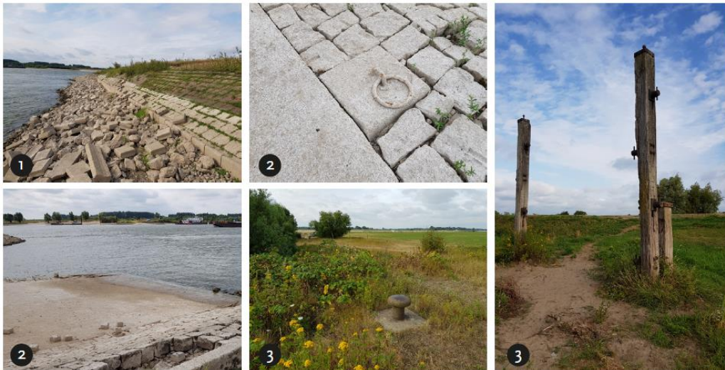
Figuur 5-9 Kenmerkende elementen van de veerhaven ([1] overbescherming, [2] veerstoep, [3] aanlegvoorzieningen bolden en meerpalen)
