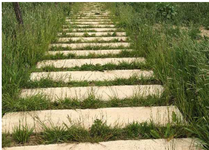
Figuur 7-19 Betonnen elementen geveegd (1,5m x 0,5m, tussenruimte 0,2), gelijk aan karrespoor en paden
