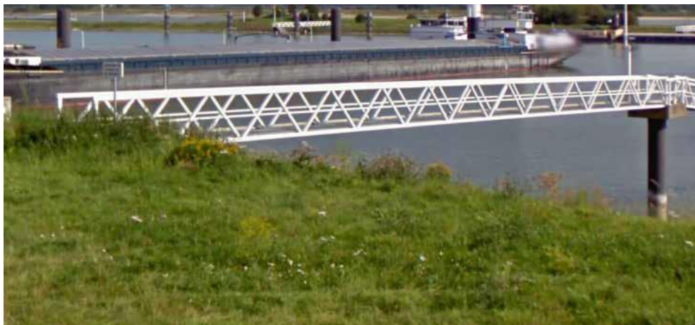
Figuur 3-3 referentiebeeld stijl en uitstraling vakwerk loopsteiger (kleur wijkt af)
