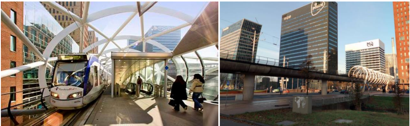
Foto 3-3 Voorbeelden Lightrail, rechts: Beatrixlaan Den Haag 'netkousconstructie' (foto: Cyclomedia)
