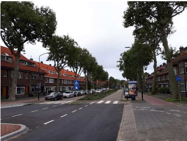
Foto 2-11 Binckhorstlaan deel Voorburg-West (bron: gemeente Den Haag, 2020)
