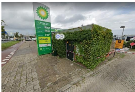
Foto B4-2 Pand bij Binckhorstlaan 100 (bron: Google streetview)
