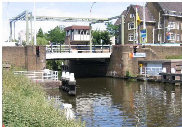
Figuur 68: Foto van de Geestbrug
