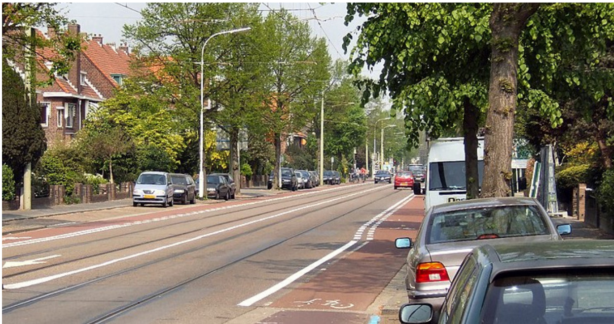
Figuur 48: foto van de Princess Mariannelaan (richtings station Voorburg)
