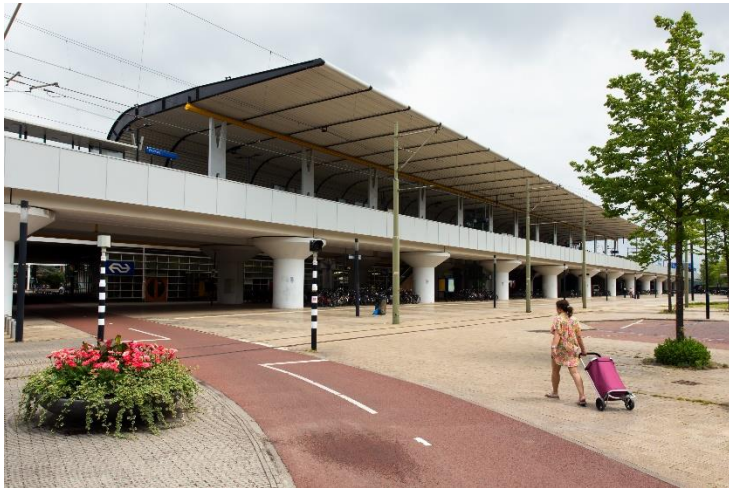
Figuur 14. Huidige situatie station Voorburg
