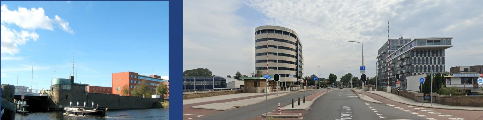
Figuur 3.10: Huidige situatie Binckhorstbrug (Den Haag).
