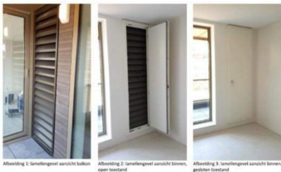
Figuur 4.5 Principe geluidwerend louvre (Comfortbox) aan de binnenzijde afsluitbaar
