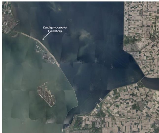
Figuur 5-2: Locatie van de zandige vooroever van de Houtribdijk
