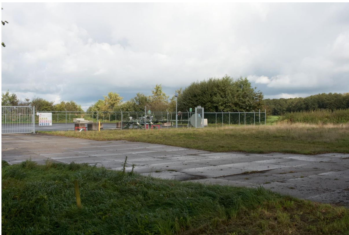
Figuur 17. Locatie 9 betreft de bestaande gaswinlocatie Vinkega aan Westvierdeparten. Foto gezien richting het noorden.
