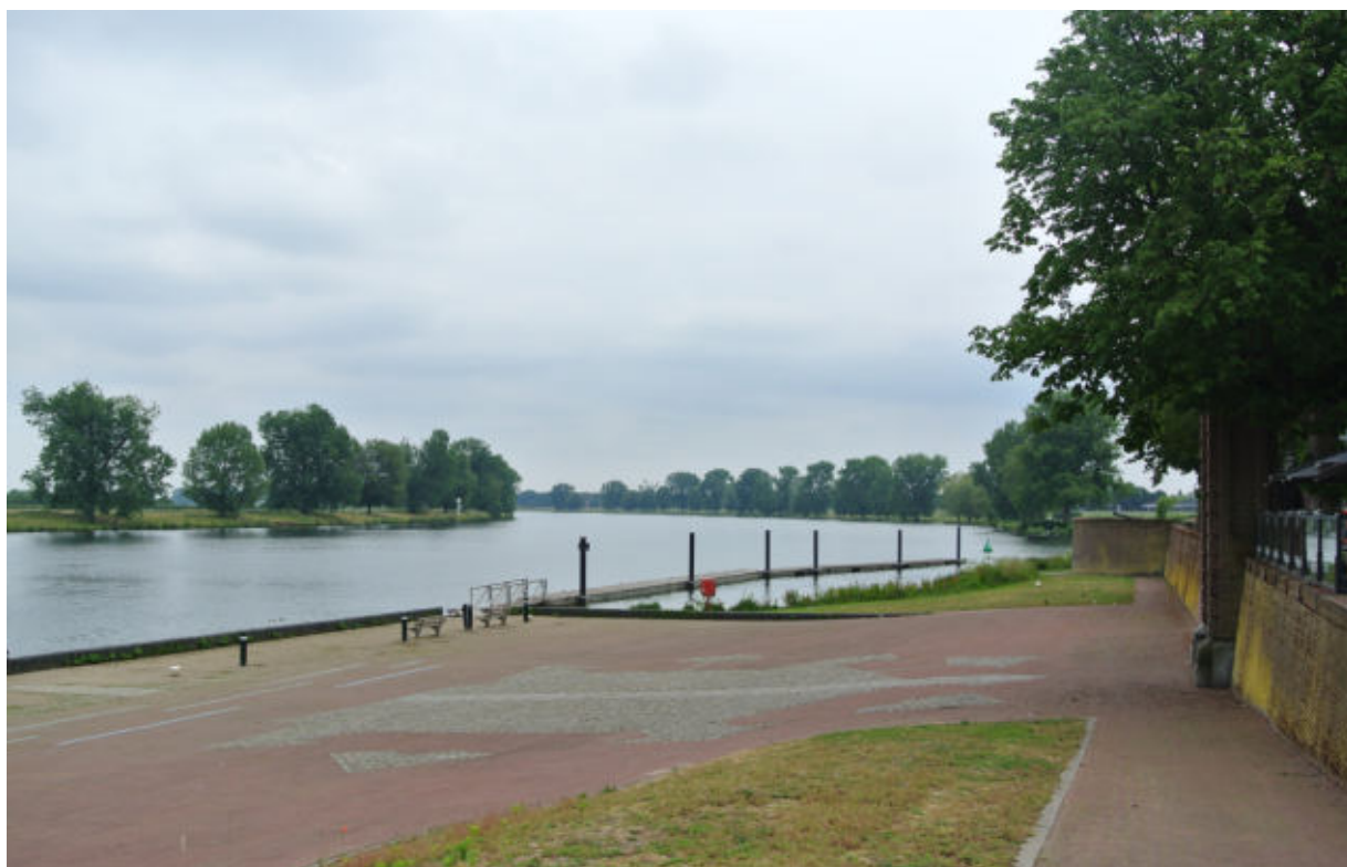
Fig. 95 Maaskade en Vestingmuur
