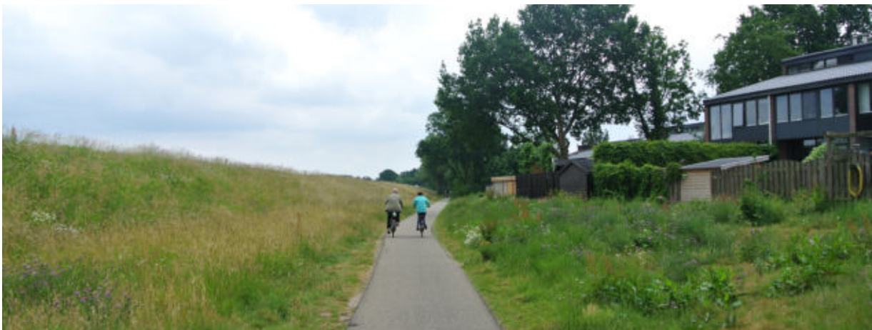
Fig. 100 Fietspad binnendijks en woningen Dokter Kanterslaan
