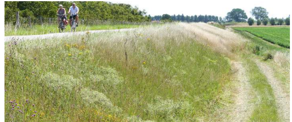
Fig. 6.4.2 Dijkvoetpad onderaan de dijk door het gehele plangebied
