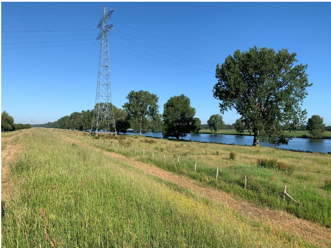
Figuur 7: De dijk ter hoogte van Linden, waar een fietspad zou kunnen worden gerealiseerd
