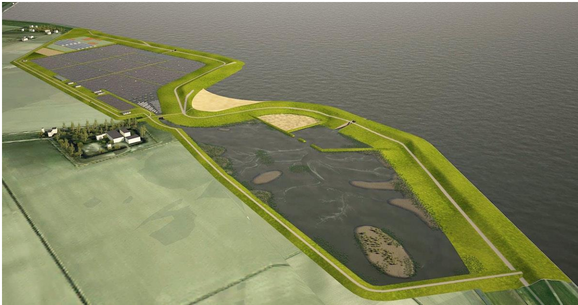
Afbeelding 6.9 Dubbele dijk pilot als onderdeel van de dijkversterking Eemshaven- Delfzijl (Programma Eems Dollard 2050 n.d.)
