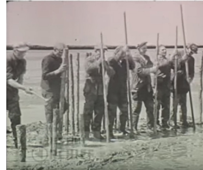
Afbeelding 2.2 De aanleg van rijshouten dammen (uit de film Van waddenzand tot vruchtbaar land)
