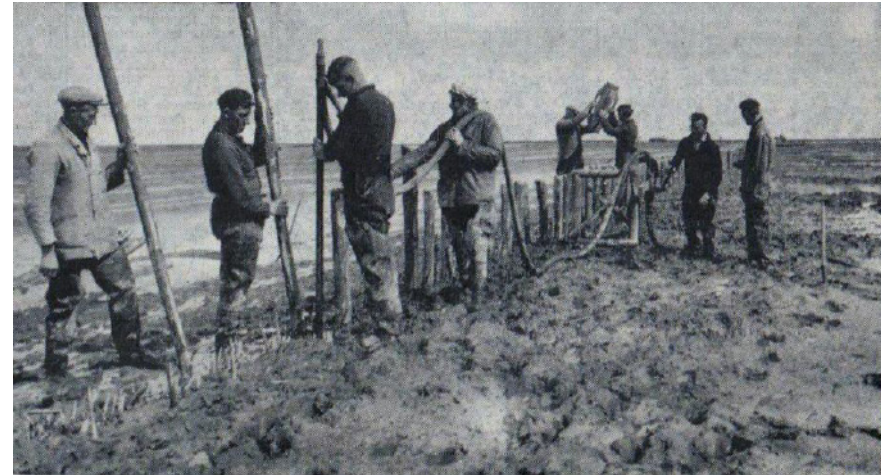
Afbeelding 2.18 Slikwerkers bouwen een nieuwe rijsdam in de bezinkvelden. Tussen de palen worden takkenbossen gelegd. (Bron: Leeuwarder Courant, 09-05-1959)
