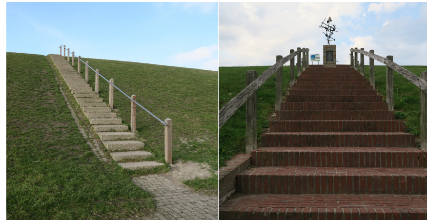
Een standaard trap in het buitengebied is terughoudend en sober vormgegeven. Een gemetselde trap in Wierum met halverwege het Vissersmonument is daarentegen meer bijzonder vormgegeven naar aanleiding van de dorpscontext en het monumentje.
