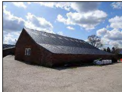
Figuur 4. Werkschuur op onderzoekslocatie (noordzijde).
