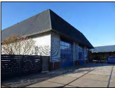
Figuur 3. Loods op zuidwestelijk deel van onderzoekslocatie.
