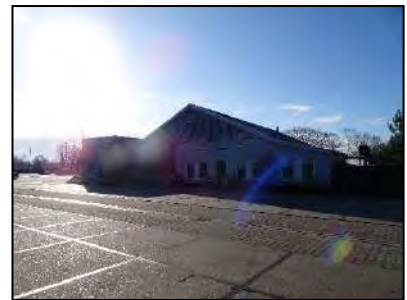
Figuur 5. Kantoorgebouw op zuidwestelijk deel van onderzoekslocatie.
