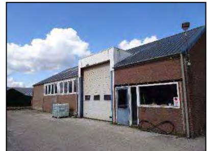
Figuur 5. Werkschuur op onderzoekslocatie (zuidzijde).
