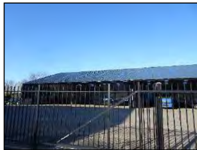
Figuur 4. Loods op westelijk deel van onderzoekslocatie.
