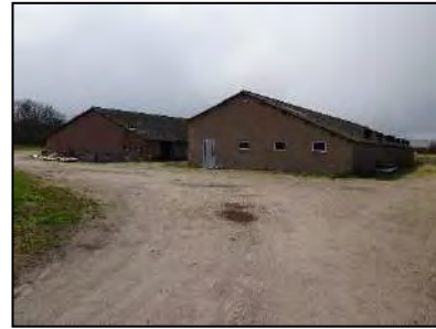
Figuur 5. Te slopen voormalige varkensstallen op de onderzoekslocatie.
