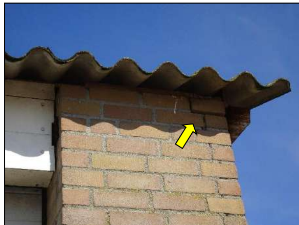
Figuur 12. Geschikte invliegmogelijkheden voor vleermuizen; open voegen.
