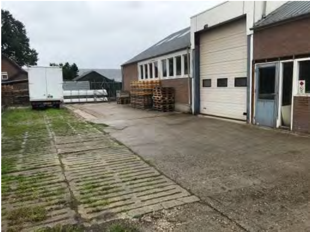
Foto 3: schuur met werkplaats en opslagruimte en betonverharding en voormalige mestgoot
