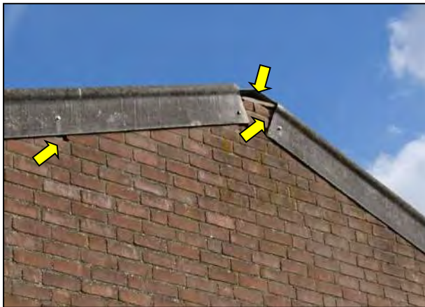
Figuur 10. Geschikte openingen (gele pijlen) voor vleermuizen; open nok en voegen.
