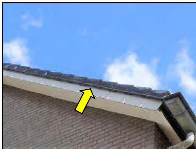
Figuur 17. Toegang voor vleermuizen in de vorm van ruimtes onder overhangende dakpannen bij het woonhuis.
