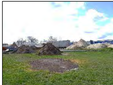
Figuur 7. (tijdelijke) opslag van grond op het noordoostelijk gelegen grasland.
