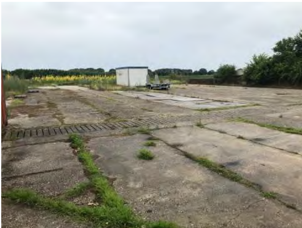
Foto 6: stallingsplaats voorzien van stelconplaten
