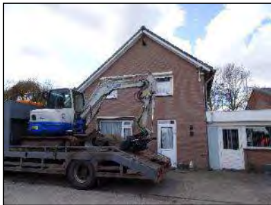
Figuur 3. Woonhuis op onderzoekslocatie.
