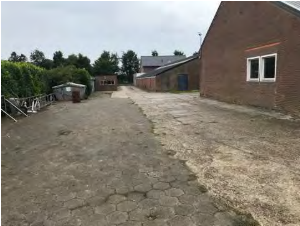
Foto 9: Achterzijde terrein voorzien van betonverharding en betontegels
