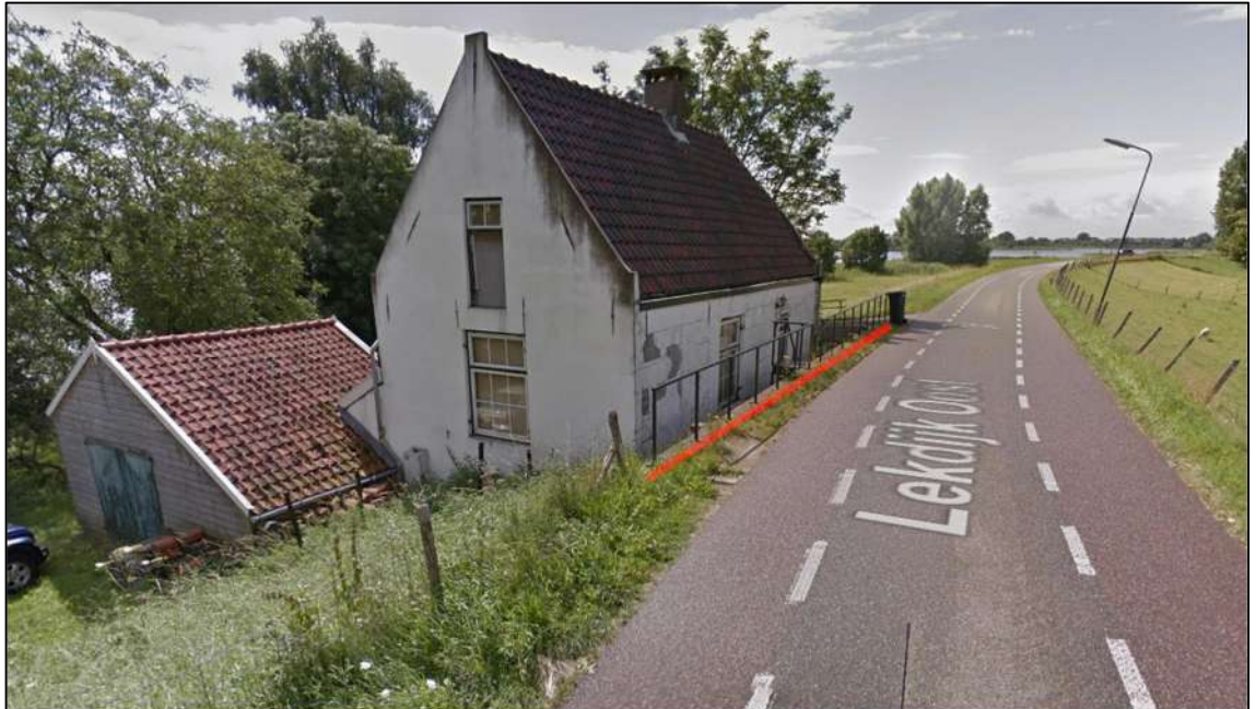
Figuur 6 Bijzondere elementen (ter hoogte van de rode lijn zit de bovenzijde van de L-wand)
