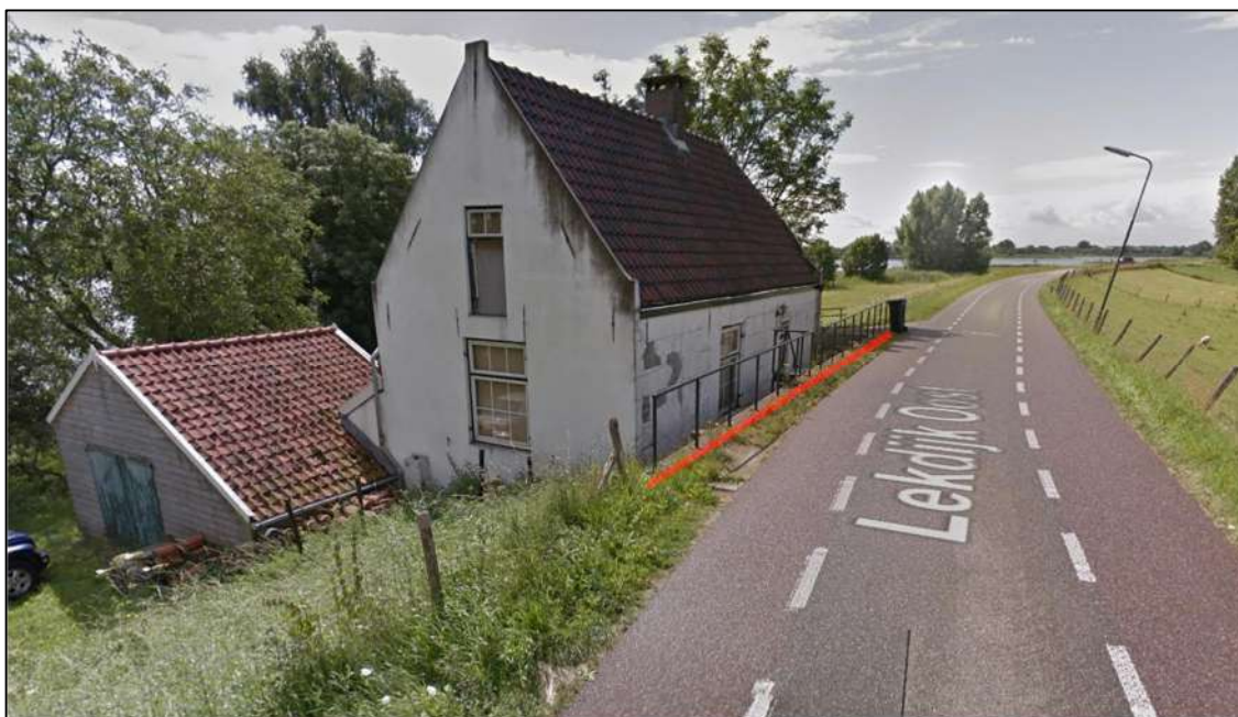
Figuur 11 Bijzondere elementen (ter hoogte van de rode lijn zit de bovenzijde van de L-wand)
