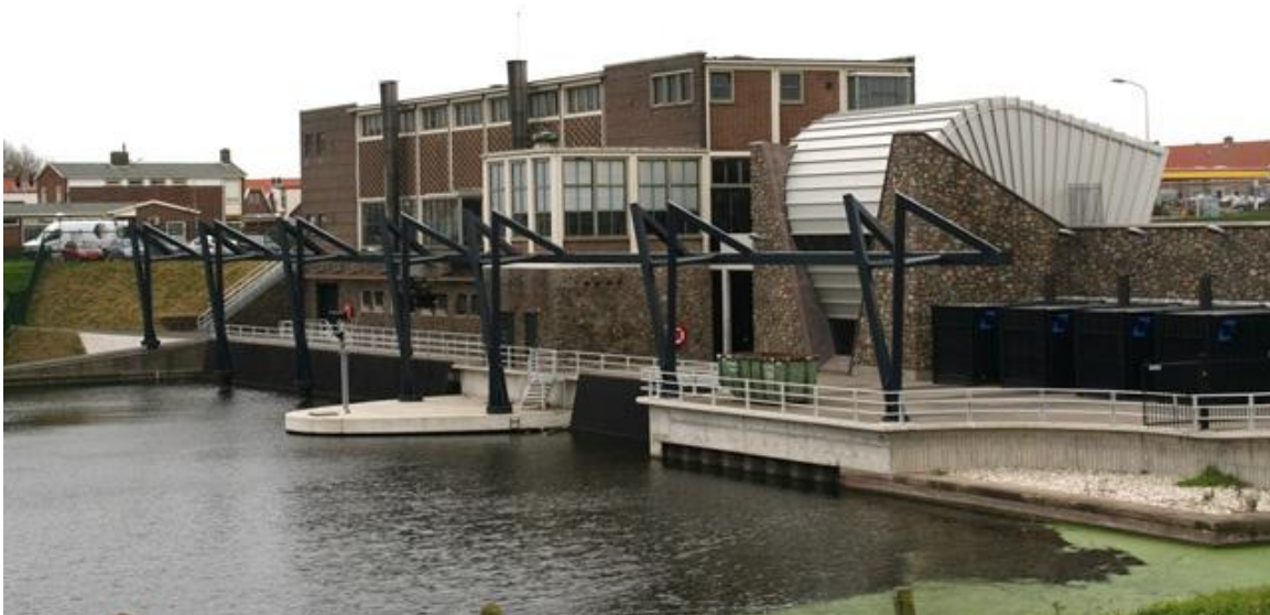
Afbeelding 3.5 Voorbeeld gemaal van Katwijk met capaciteit 94 \text{ m}^3/\text{s} (met oude en nieuwe pompen, www.rijnland.net )
