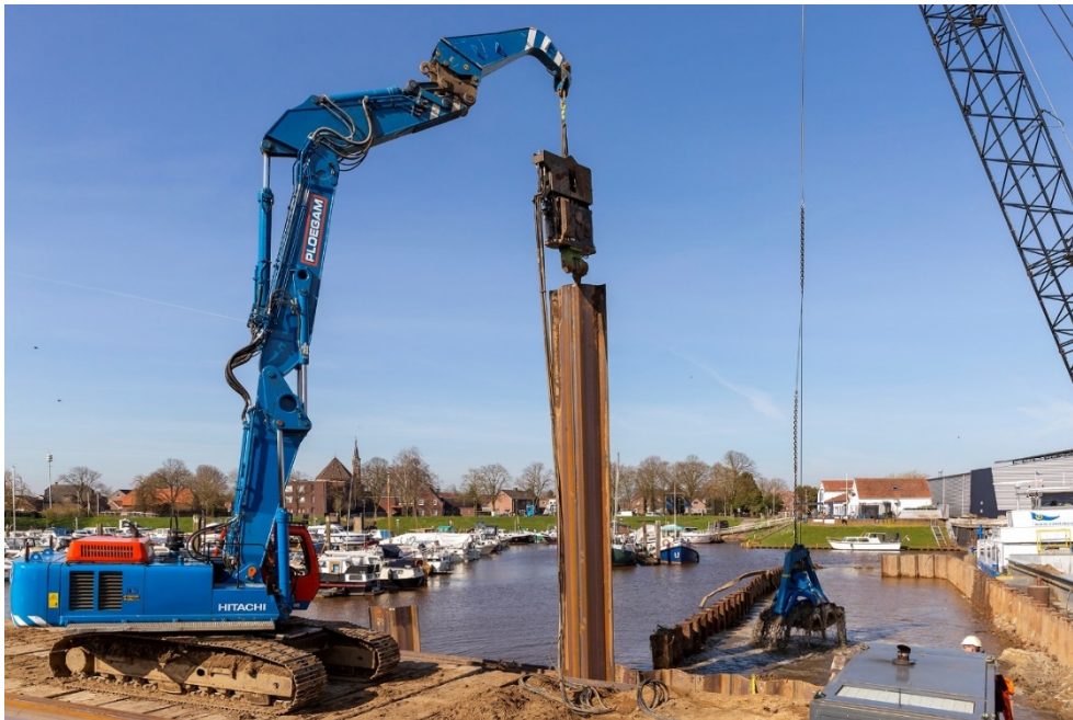
Figuur 2.61 Impressie van het aanbrengen van damwanden
