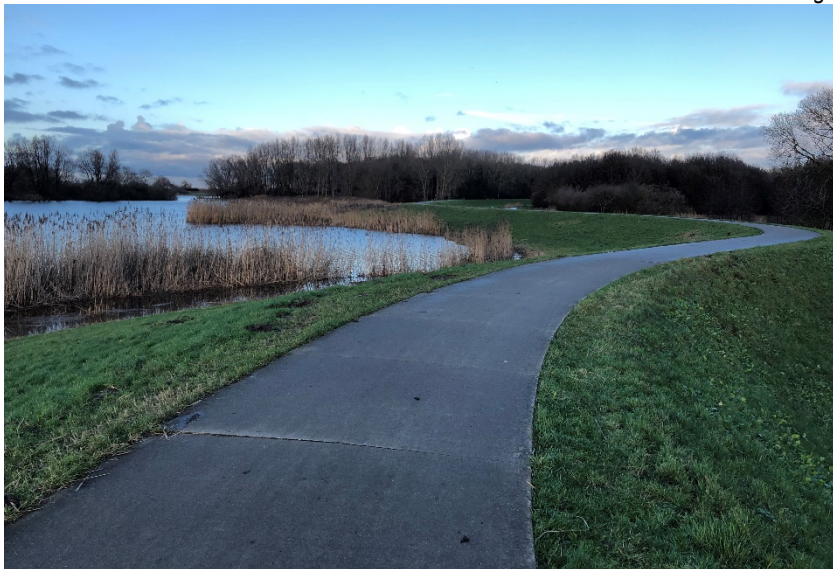
Foto 2.49 Waterkering langs de Westerveldse kolk
