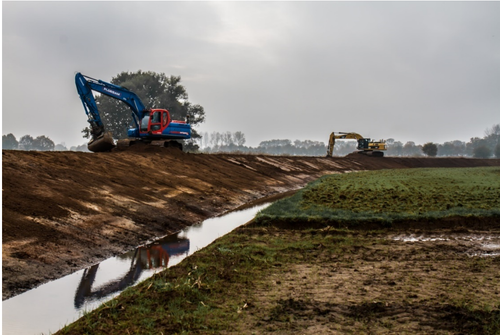
Figuur 2.60 Impressie van het ontmantelen van een deel van een dijk zoals ook bij dit project beoogd is
