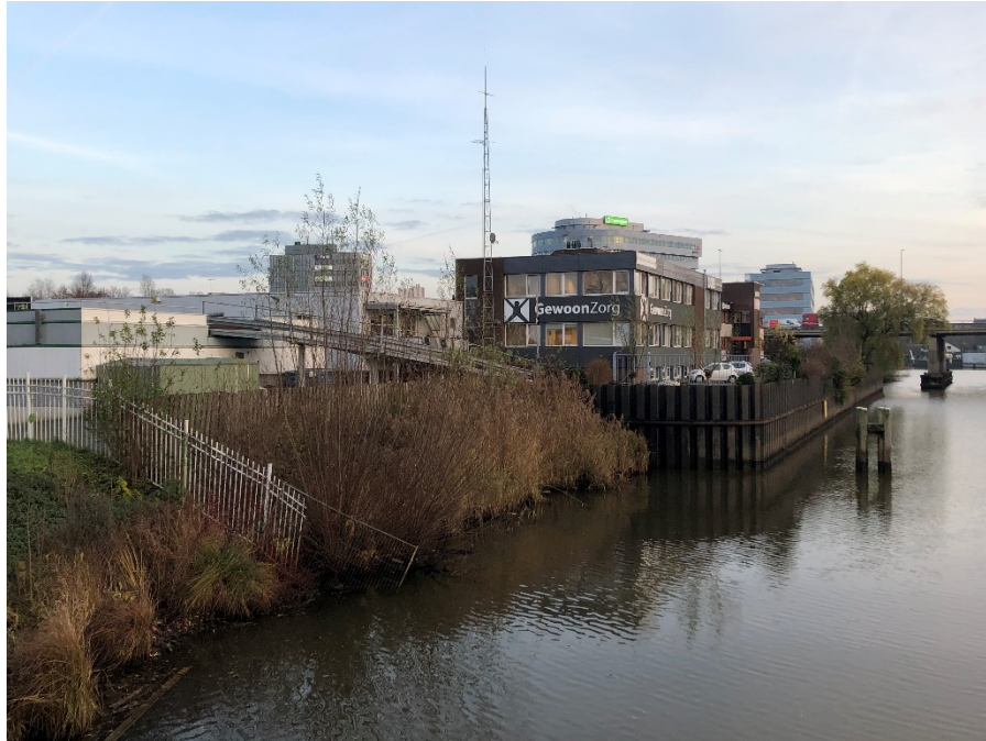
Foto 2.30 Oeverconstructie van stalen damwand en groene oever aansluiting Blaloweg
