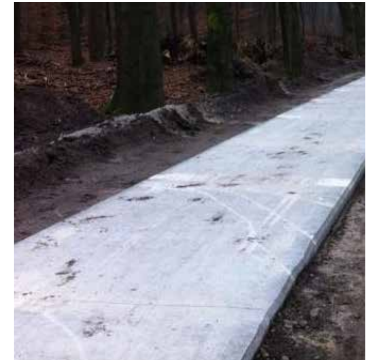
Hoofdmateriaal, SITU-beton (vormgegeven met dilatatievoegen)
