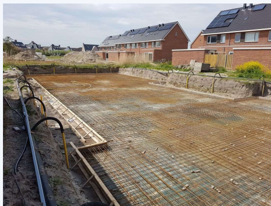
Betonplaat op staal, Voorhout
