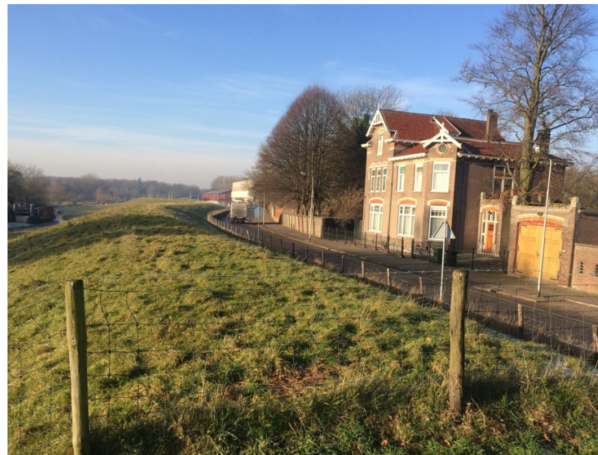
Figuur 3-23: Voornamen kleinschalige bebouwing in een groene omlijsting aan de Ringdijk t.h.v. Slikkerveer
