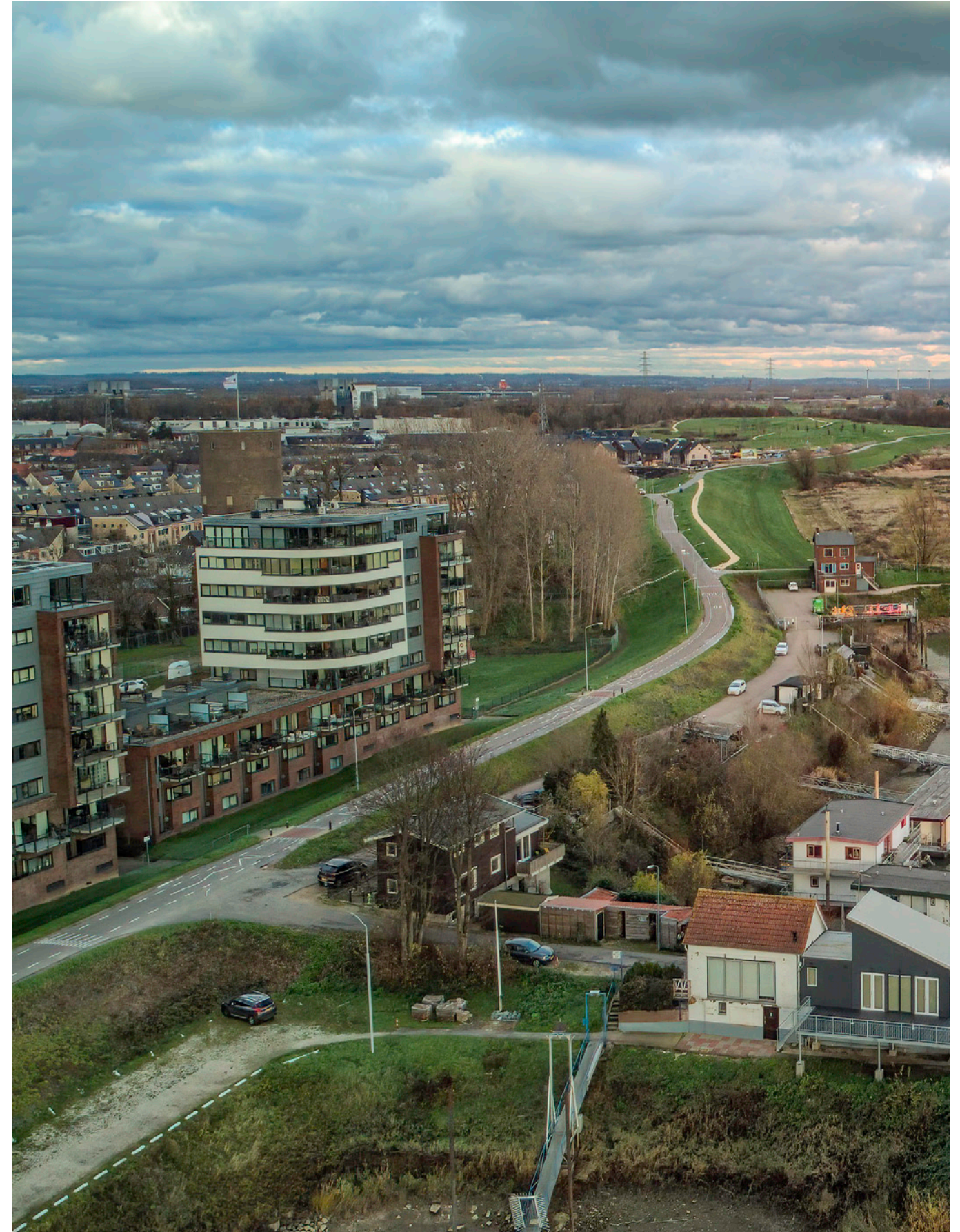
Foto van de kruising Echteldsedijk en de Nieuwe Havendijk (voorgrond), oostelijke havenkom en Fluvia Tiel (Deeltraject 2)
