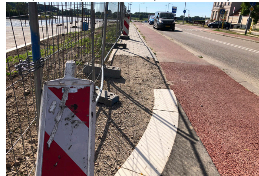
Aandachtspunt: opsluitband eindigt nu tussen het voetpad en het fietspad en komt iets naar binnen te liggen (in lijn van de keerwand)
