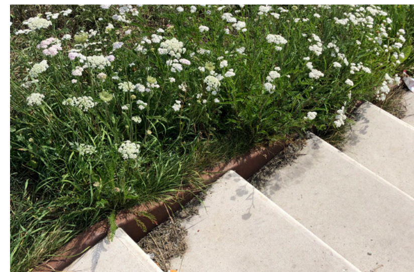
Aandachtspunt: opsluitband eindigt nu tussen het voetpad en het fietspad en komt iets naar binnen te liggen (in lijn van de keerwand)
