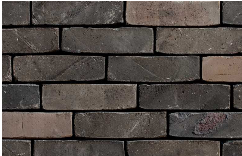
Referentie baksteen bekleding keermuur binnenzijde: bruingrijs, gemêleerd, groot formaat (DO-opgave) Bron: VANDE MOORTELV NV
