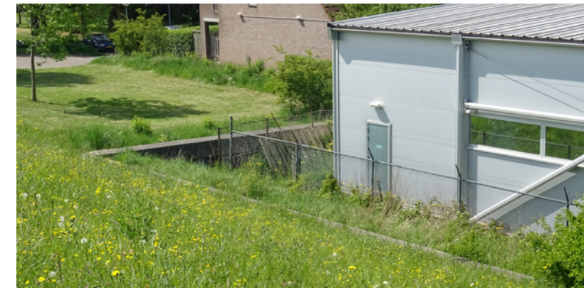
Keermuur bij ALDI-terrein verwijderen
