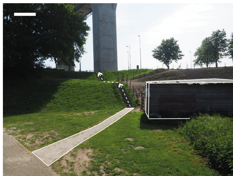
Als voetganger wordt langs een paardenwei omhoog geleid vanaf de Latensteijnse Rondweg om bij de sluis te komen. De trappen zijn steil en er is geen 'fietsgoot'.
