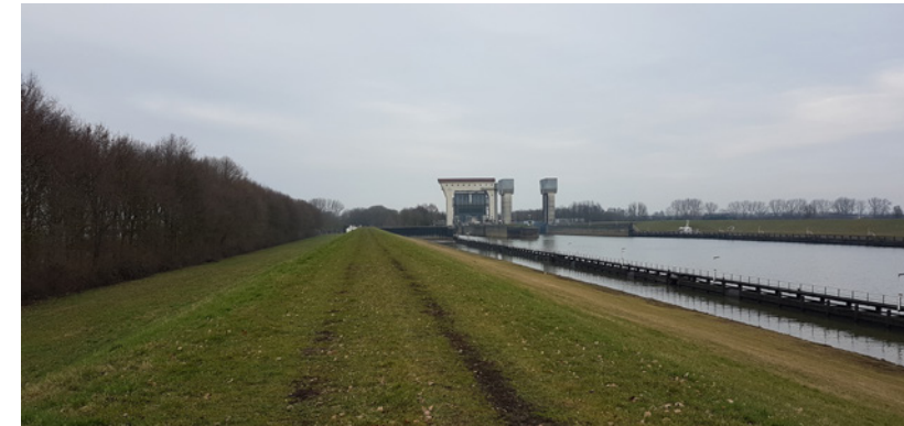
Ontbrekende schakel in het fietsroutenetwerk: Voorhavendijk
