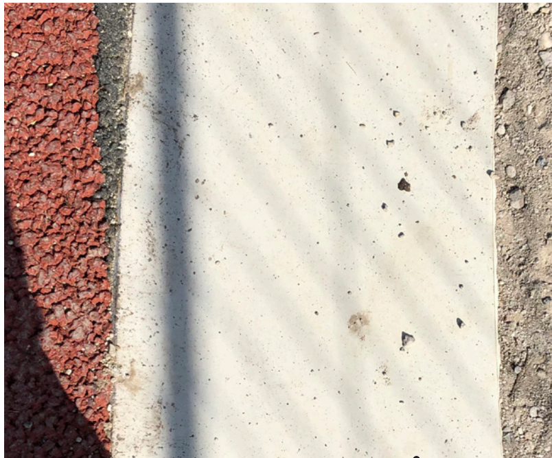
Muurtje van lichtgrijs zelfverdichtend beton van 40cm, zoals toegepast op Waalplaat
