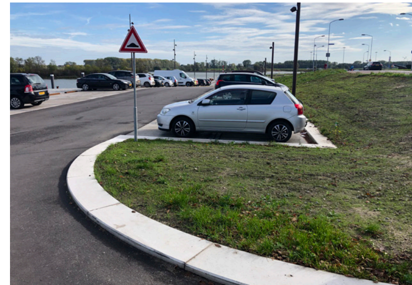
Brede opsluitband loopt door vanaf de Waalplaat naar de Havendijk
