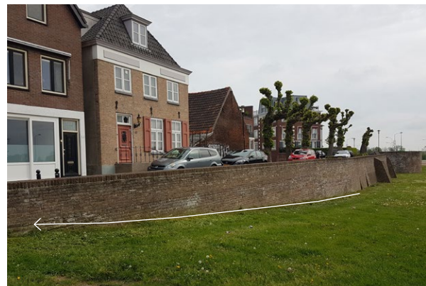
Foto van het oplopend talud langs de stadmuur, in de hoek bij de aansluiting op de waterkering richting Bellevue
