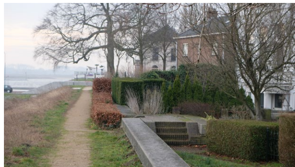
Inpassing van de damwand langs de woningen met een beukenhaag en zorgvuldige vormgeving van de trappen.
