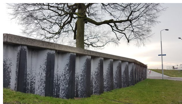
Onafgewerkte zichtbare damwand bij de monumentale beuk
