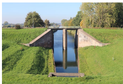
De sluis met doorkijk op het inundatiekanaal
