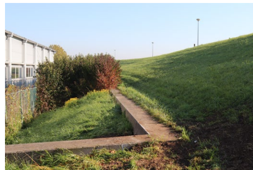
Taludverkorting met damwand bij Aldi-terrein
