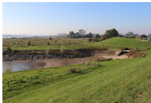
Niet functionerende doorlaat in de dijk
