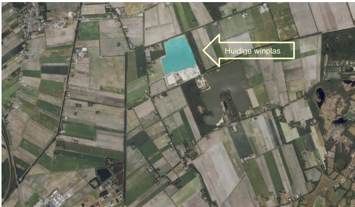
Figuur 4. Ligging huidige winplas en klasseerinstallatie (luchtfoto cyclomedia, 2020)
