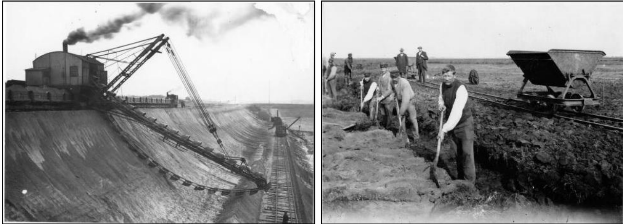
6 en 7. Twee foto's uit 1915. Op de linker foto zien we een excavateur aan het werk. De 'ijzeren man' vormde een besparing op loonkosten van de steeds duurder wordende arbeiders. Op de rechter zijn waarschijnlijk geïnterneerde Belgen te zien. Op de achtergrond houdt de opzichter een oogje in het zeil.
