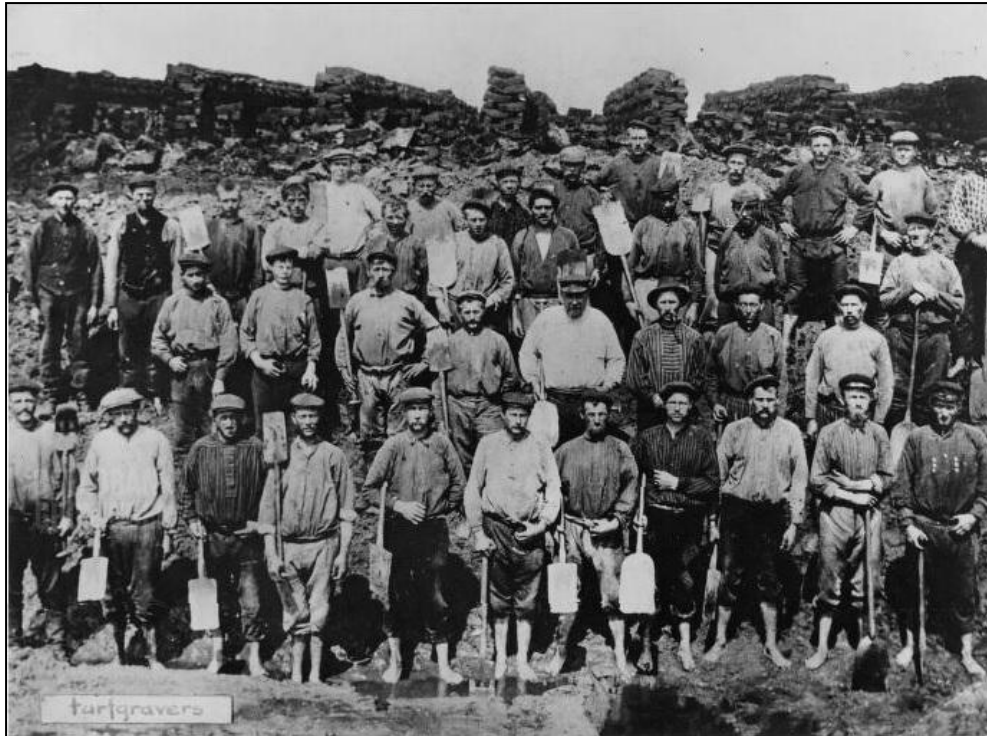
8. Vledderveen, ca. 1905. De wijken in het Vledderveen werden vrijwel geheel handmatig gegraven. Vergelijk deze foto met de foto's van de kanalisatie van Westerwolde in hoofdstuk 5.
