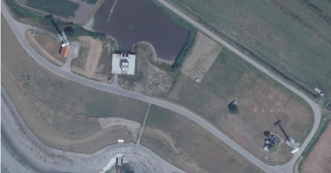
Afbeelding 5.6 Locatie gemaal Schore
