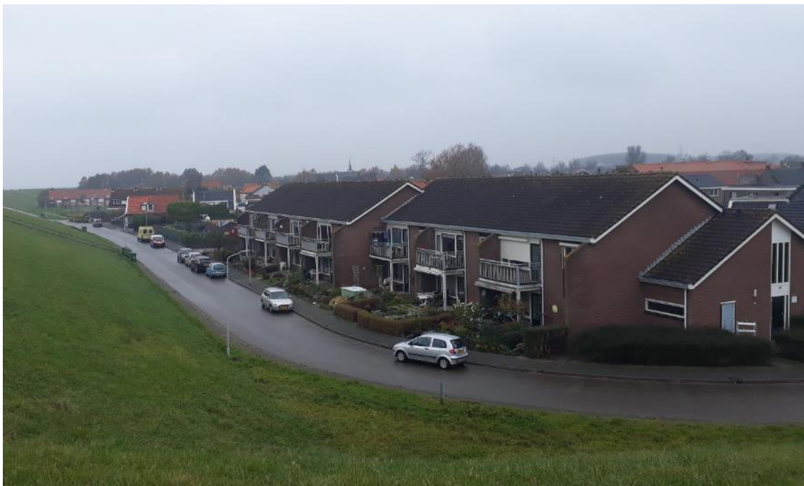
Afbeelding 5.1 Woningen Veerweg (woningen Maasstraat/Zeedijk zichtbaar in de verte)
