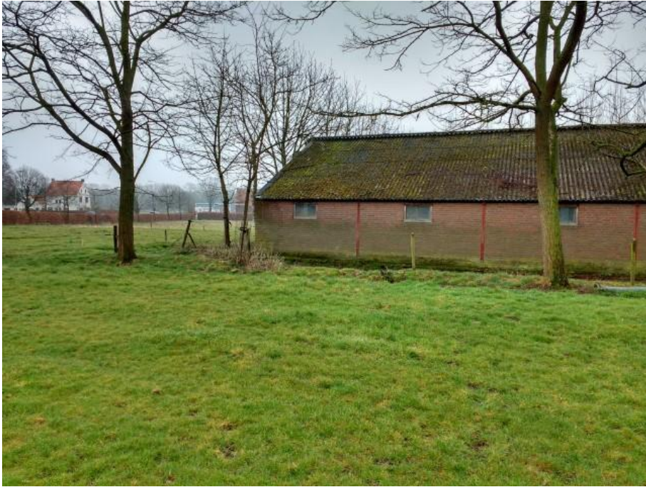
Foto 69: Kasteelweg 5 te Baexem (dak met asbesthoudende golfplaten)
