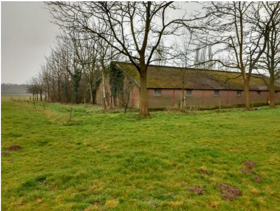
Foto 70: Kasteelweg 5 te Baexem (dak met asbesthoudende golfplaten)
