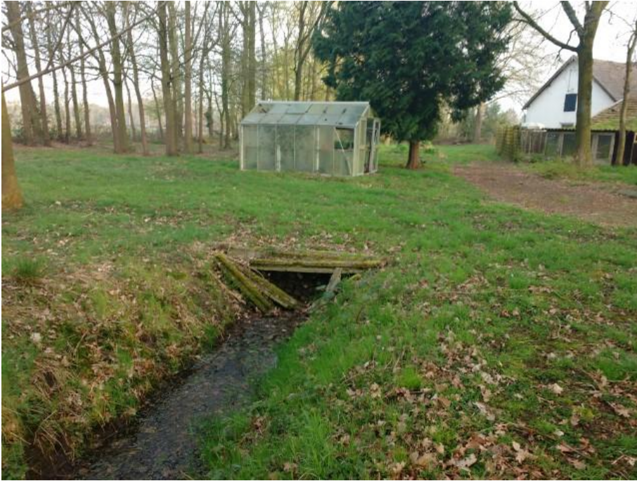
Foto 30: Rijksweg zuid 4 te Kelpen (greppel met op het eind, asbesthoudende golfplaten, met op de achtergrond een glazen tuinderskas)
