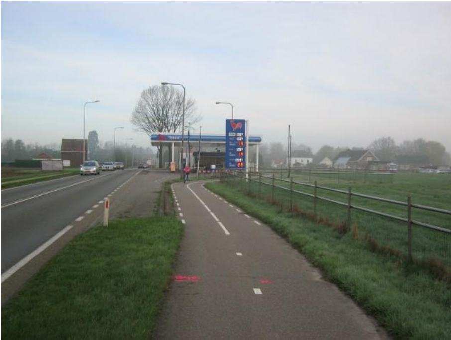
Foto 4: N280, richting Baexem (ter hoogte van het tankstation)
