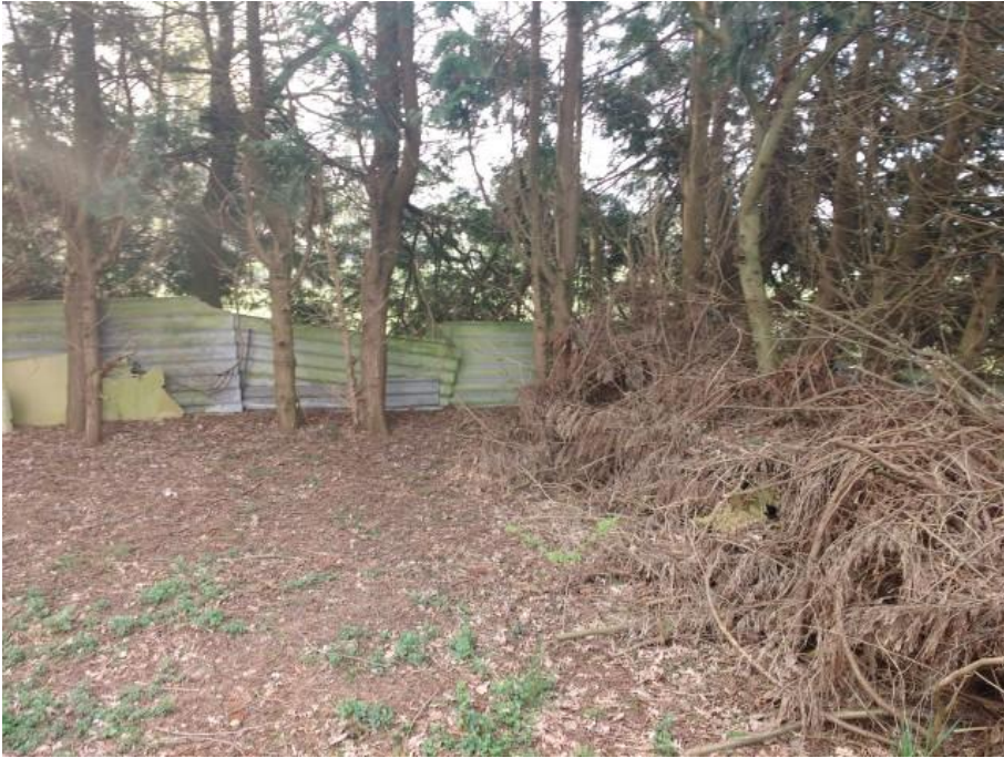
Foto 34: Rijksweg zuid 4 te Kelpen (schutting met asbesthoudende golfplaten op het achterste deel van het perceel)
