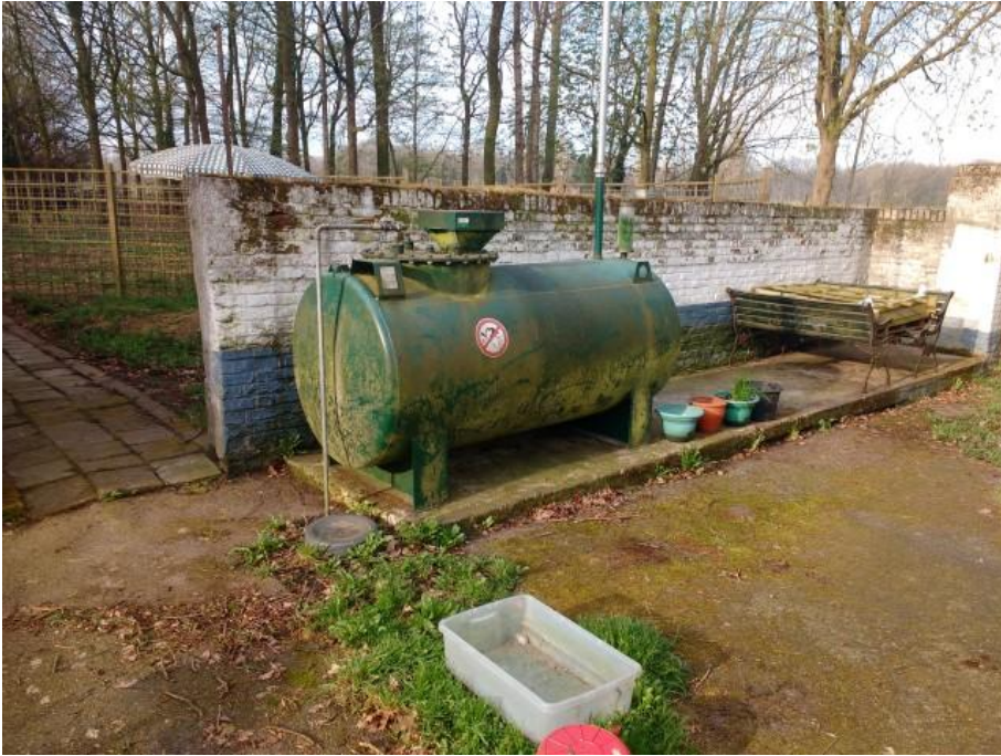
Foto 38: Rijksweg zuid 4 te Kelpen (opslag bovengrondse opslagtank op betonvloer achter de woning)
