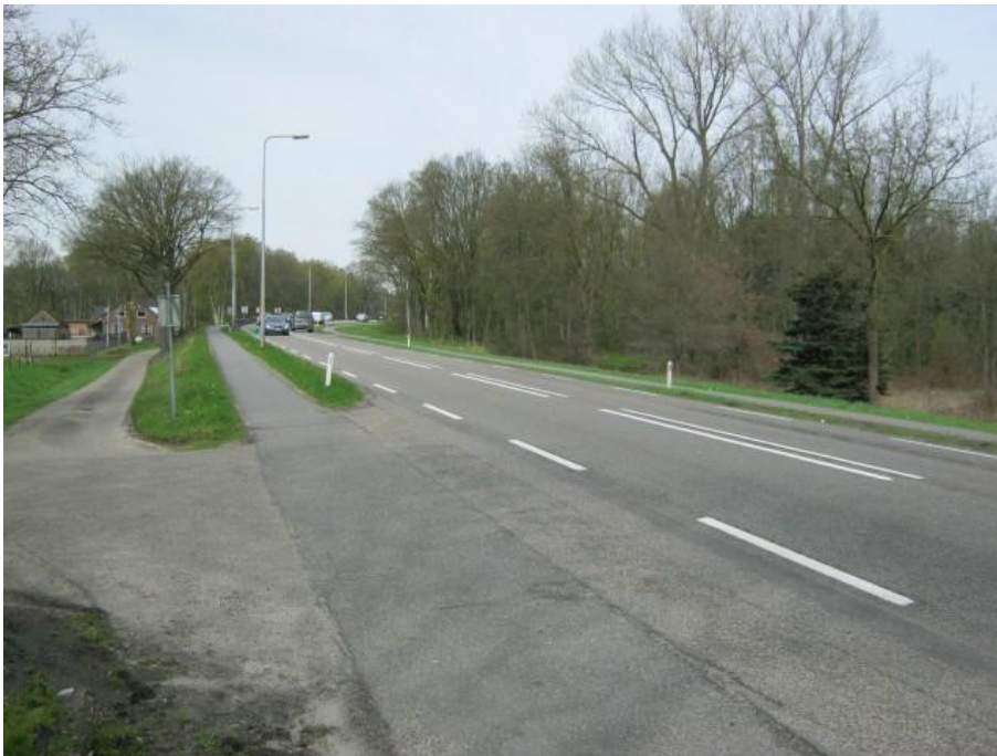
Foto 32: N280, begin van het grondlichaam Kelperbrug
