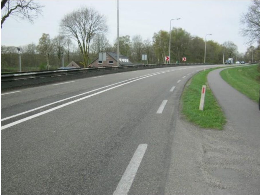
Foto 33: N280, grondlichaam Kelperbrug
