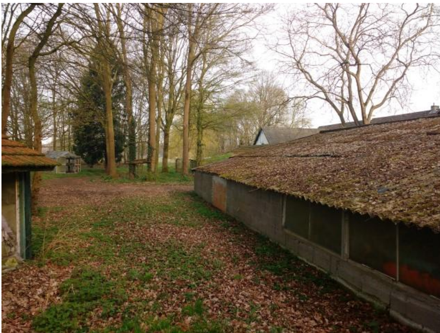
Foto 29: Rijksweg zuid 4 te Kelpen (bebouwing met asbesthoudende golfplaten midden op het perceel)
