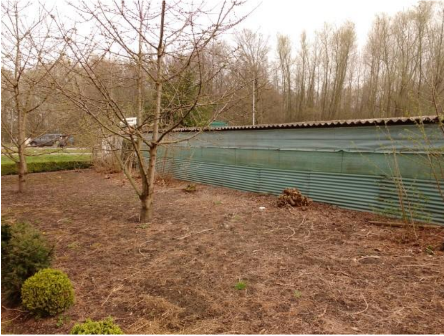
Foto 58: Grathemerweg 57 (in rapport Kelperheide 57), asbestdak op perceel Kelperheide 55
