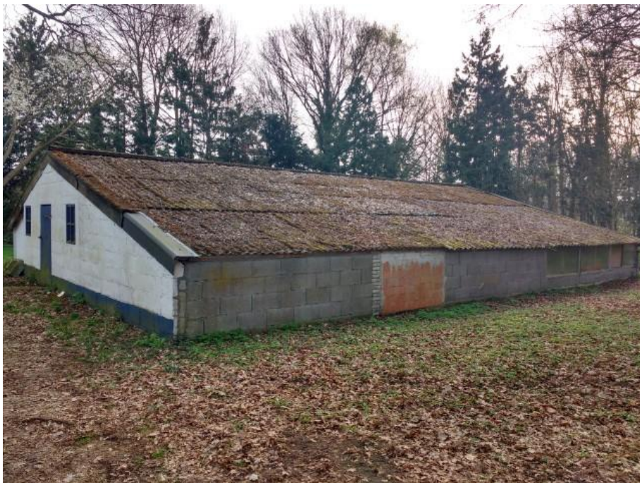
Foto 21: Rijksweg zuid 4 te Kelpen (bebouwing met asbesthoudende golfplaten midden op het perceel)
