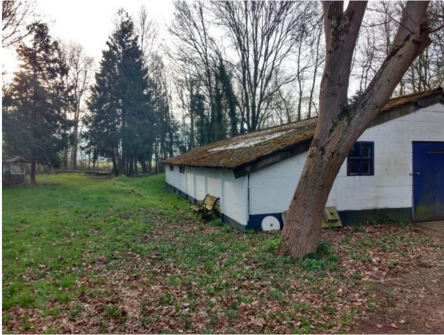
Foto 20: Rijksweg zuid 4 te Kelpen (bebouwing met asbesthoudende golfplaten midden op het perceel)
