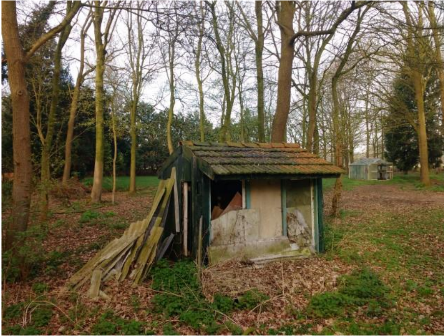
Foto 28: Rijksweg zuid 4 te Kelpen (schuurtje met dakpannen, aan de zijkant asbesthoudend plaatmateriaal, gelegen op het achterste deel van het perceel)
