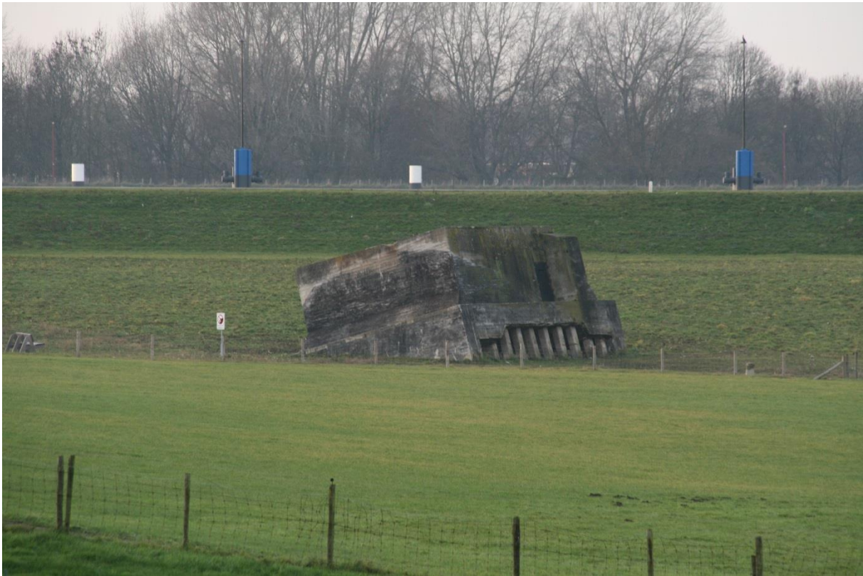
Afbeelding 7 Kazemat Vreeswijk Oost uit 1939, gelegen in de hoek tussen de Lekdijk-Noord en Lekdijk-Oost. Deze werd recentelijk verplaatst ten gevolge van het werk aan de derde kolk van de Prinses Beatrixsluizen. Bron: Foto Vestigia 2020.
