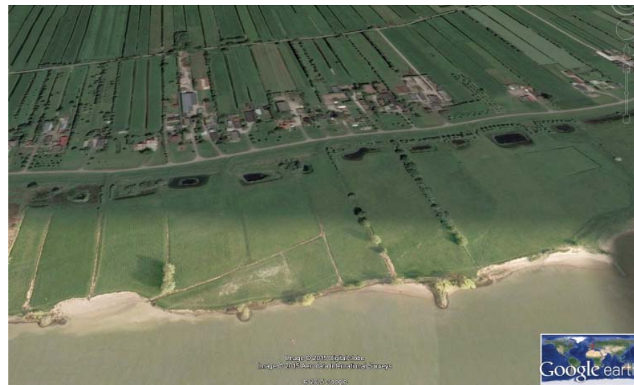
Dijk in Willige Langerak tussen een behouden gebleven en een verdrongen middeleeuwse ontginning.
