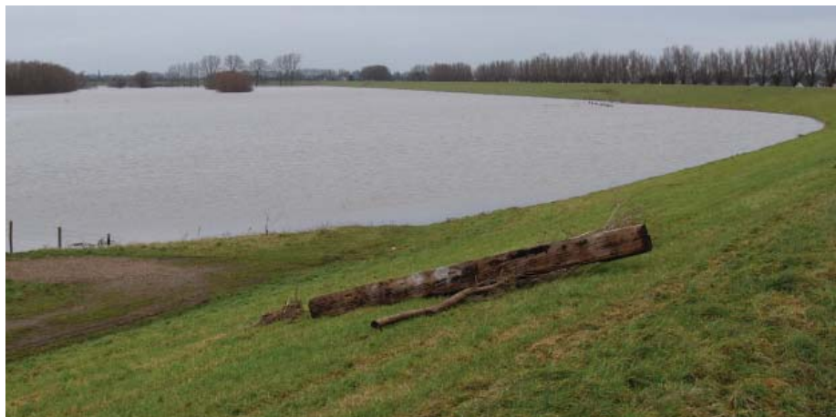
Inlaagdijk in Herwen, gebouwd om de Noorder Lekdijk te behoeden voor een catastrofe.
