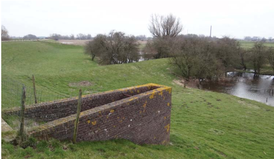
Ensemble van uitgedijkt land met rabatten, een kade en een relict van een peilschaalhuisje.
