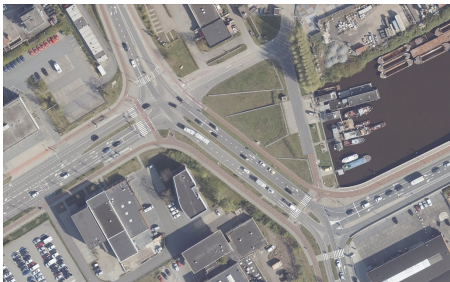
Figuur 3.7: Het kruispuntencomplex Sontweg-Sontbrug
