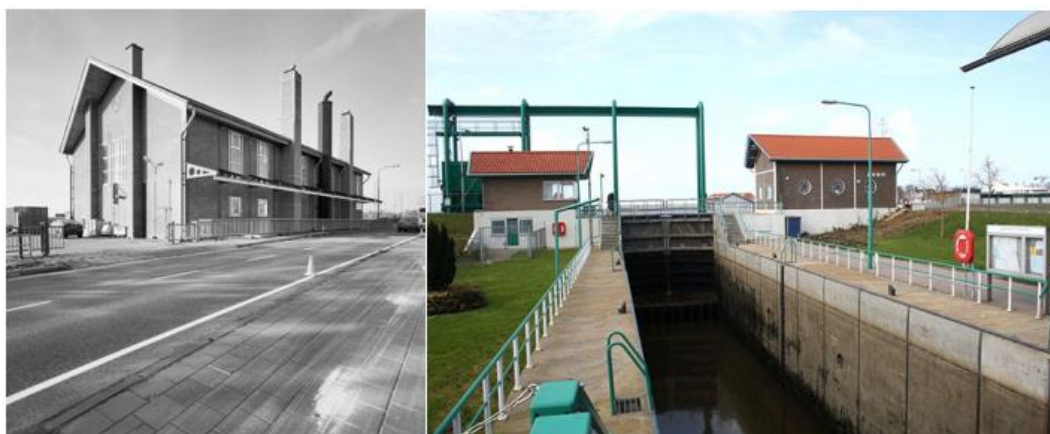
Figuur 5-30 Links: Gemaal Visserink, rechts: Sluiswachtershuisje, Schotbalkenloods en Urkersluis
