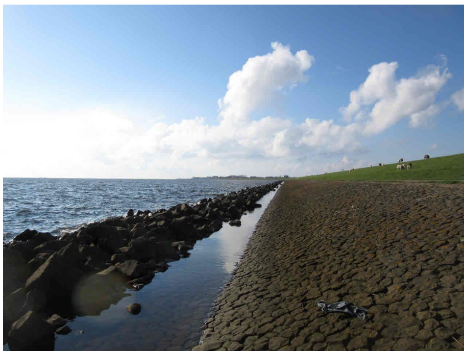
Figuur 5-3 Steenbestorting Zuidermeerdijk (noordwestelijke richting)
