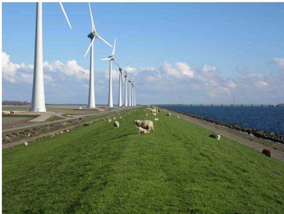
Figuur 5-2 Zuidermeerdijk met windturbines, onderhoudspad en fietspad (zuidoostelijke richting)
