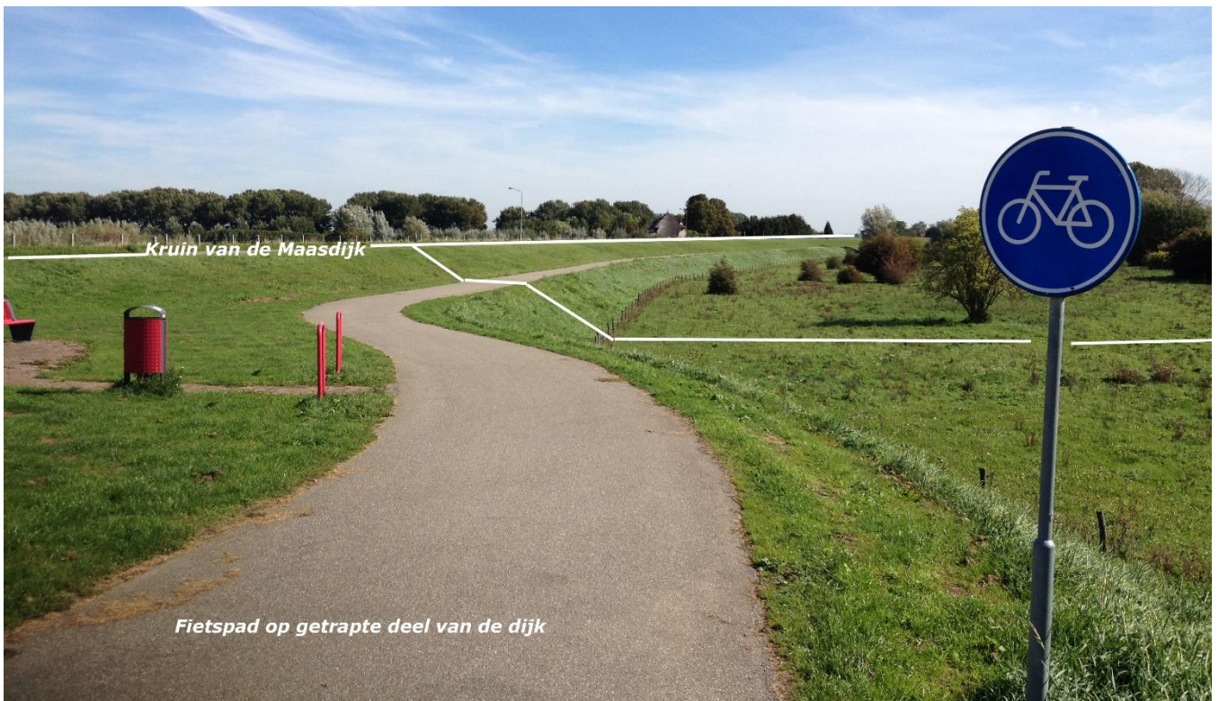
Voorbeeld van een fietspad op het Getrapte deel van de Maasdijk bij Blauwesuuis
