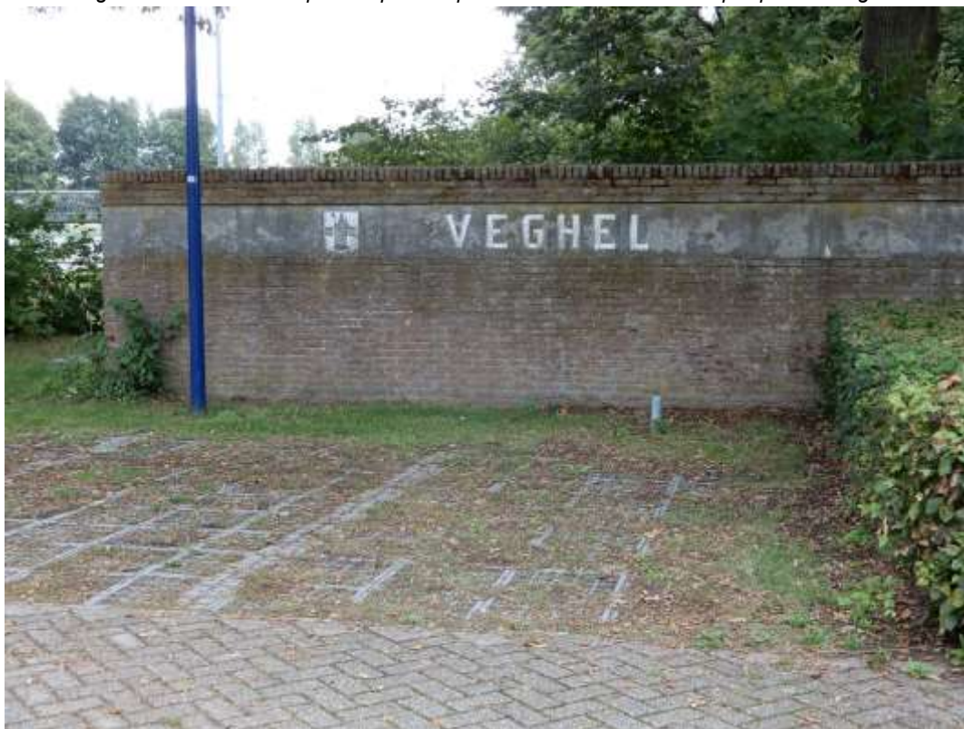
Afbeelding F111. Halfverharde parkeerplaats op Prins Willem-Alexander Sportpark in Veghel
