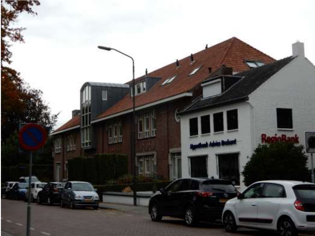
Afbeelding F121. Stationsstraat in Veghel
