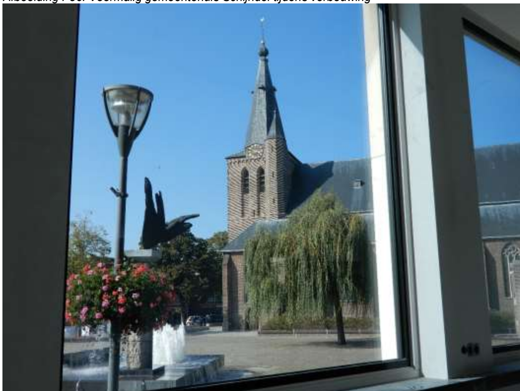
Afbeelding F56. Voormalig gemeentehuis Schijndel tijdens verbouwing
