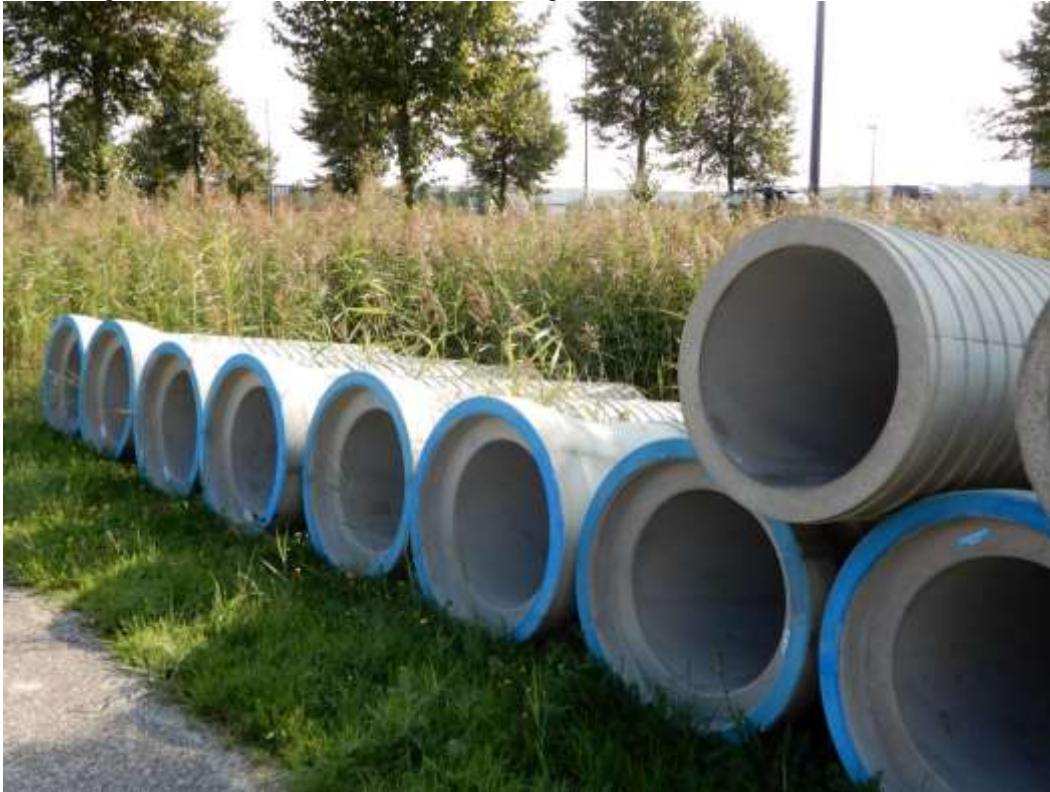
Afbeelding F54. Riolbuizen op De Dubbelen te Veghel
