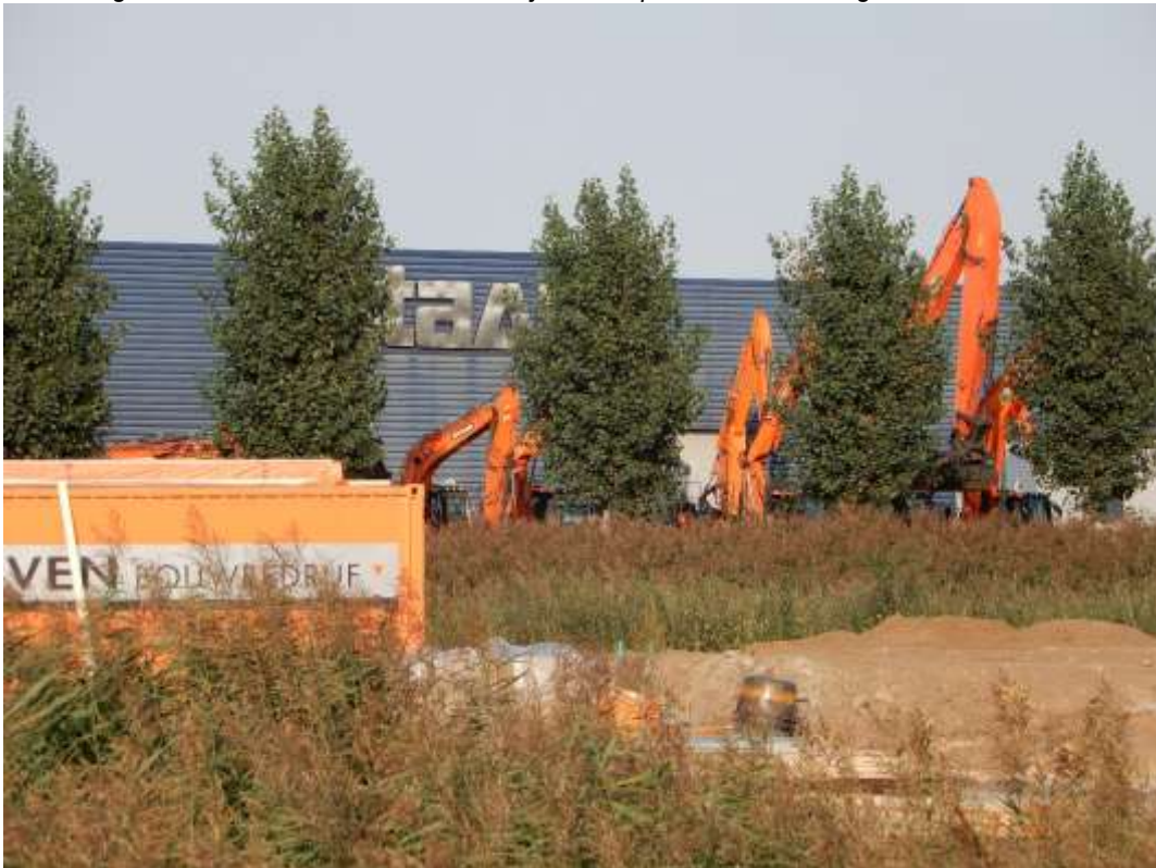
Afbeelding F50. Werkzaamheden nieuw bedrijfskavel op Doornhoek in Veghel
