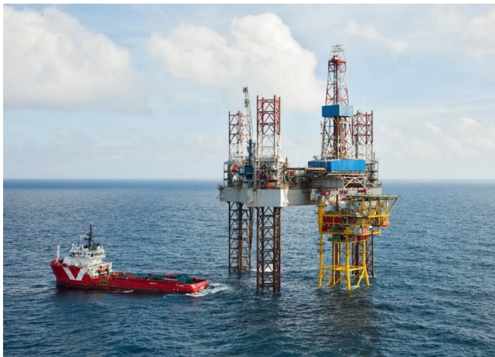
Figuur 3.1: Tijdelijke boorinstallatie ter plaatse van satellietplatform B13-A
